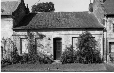
Vue de la façade. Phot. Christiane Riboulleau IVR22_19940201453Z
