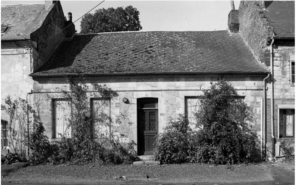
Vue de la façade.
