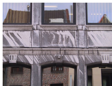
Matériaux : façade en calcaire bleu. Phot. Olivier Liardet IVR31_20065901349NUCA
