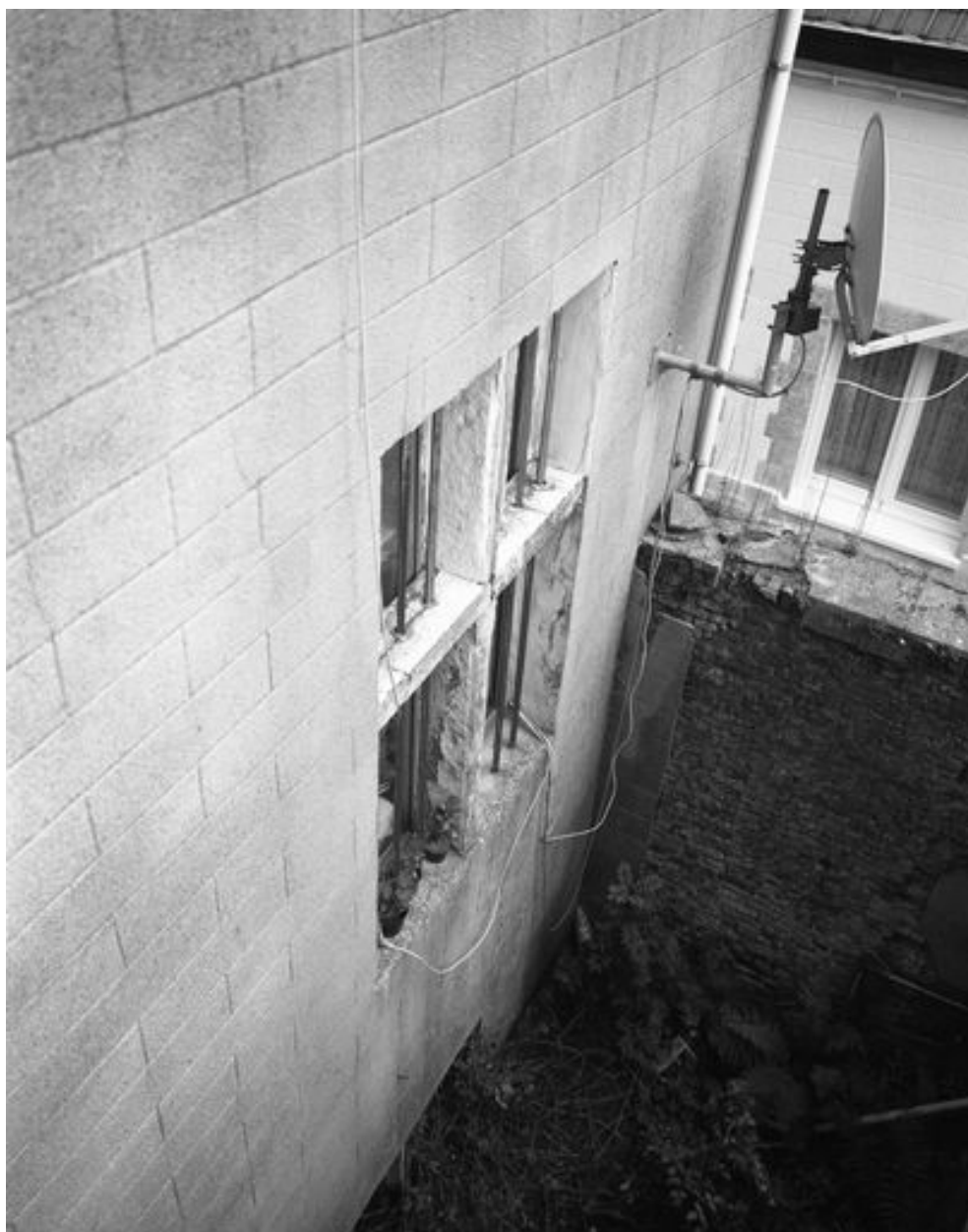
Évolution formelle : 1ère moitié 17e siècle, fenêtre à meneau et traverse (13 place Saint-Wasnon).
