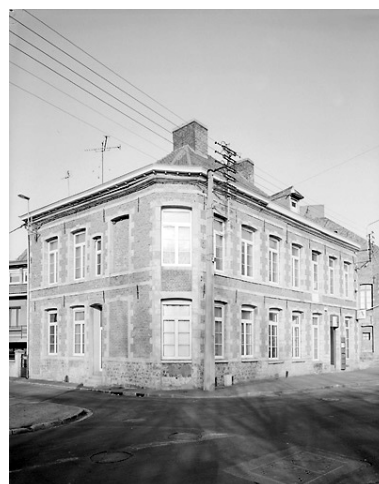
Typologie fonctionnelle : série de 3 maisons (8 rue de l'Escaut, 12 rue de l'Arsenal). Phot. Pierre Thibaut IVR31_20015902523V
