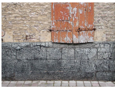
Matériaux : façade en brique avec solin de calcaire bleu, badigeon. Phot. Anita Oger-Leurent IVR31_20105900320NUCA
