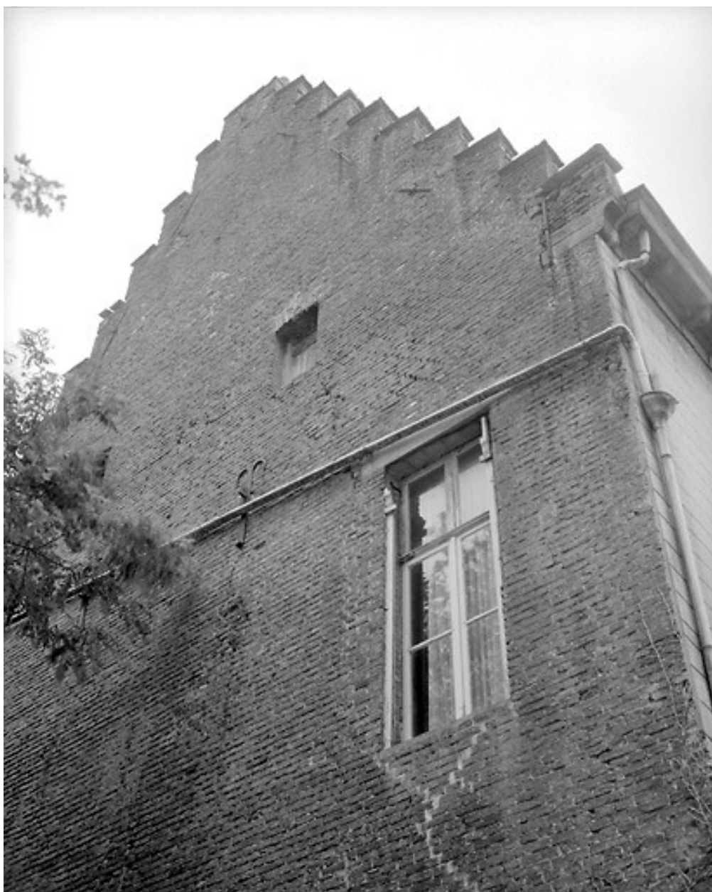
Évolution formelle : 1ère moitié 17e siècle, pignon à pas-de-moineaux (13 place Saint-Wasnon).
