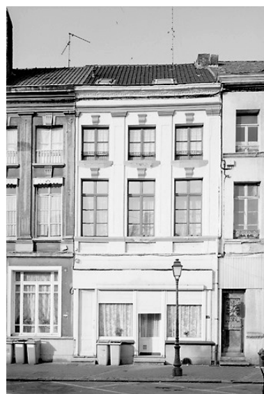
Évolution formelle : 1821 (18 place Pierre-Delcourt). Phot. Pierre Thibaut IVR31_20015902521X
