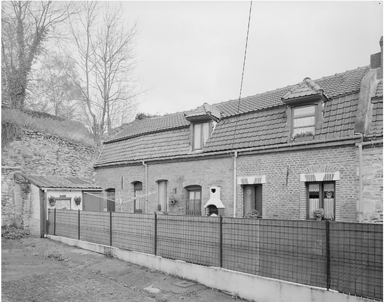
Typologie formelle : ensemble d'édifices à cour commune, courée (65 rue Neuve).
