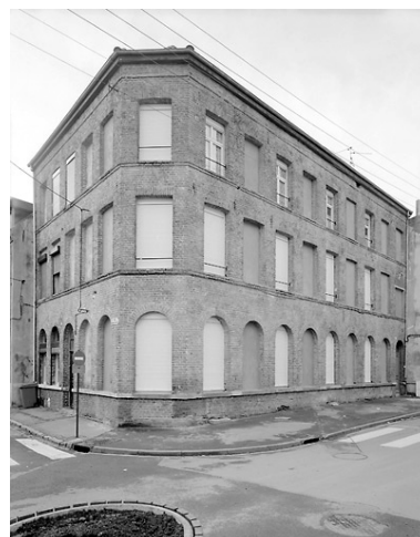
Typologie fonctionnelle : immeuble (1-3 rue Bruenne). Phot. Pierre Thibaut IVR31_20015902517V
