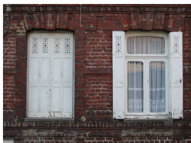
Matériaux : façade en brique. Phot. François Bisman IVR31_20065901350NUCA
