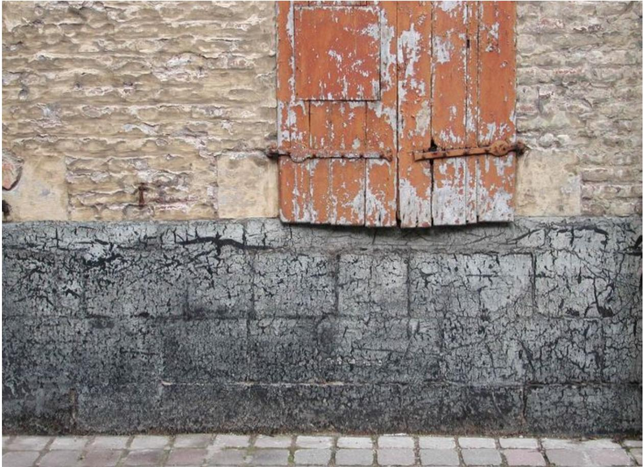
Matériaux : façade en brique avec solin de calcaire bleu, badigeon.
