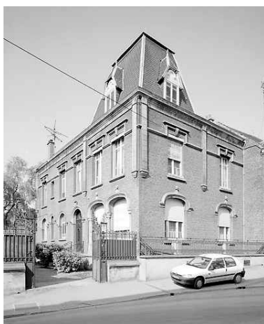
Évolution formelle : 1922 (13 rue du Collège). Phot. Pierre Thibaut IVR31_20015902546V
