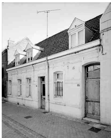
Élévations : en rez-de-chaussée (15-17 rue Saint-Barbe). Phot. Pierre Thibaut IVR31_20015902552V
