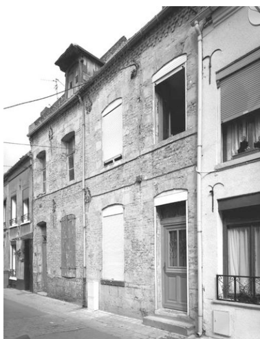
Typologie fonctionnelle : maisons jumelles (11, 13 rue du Marais). Phot. Pierre Thibaut IVR31_20015902532V
