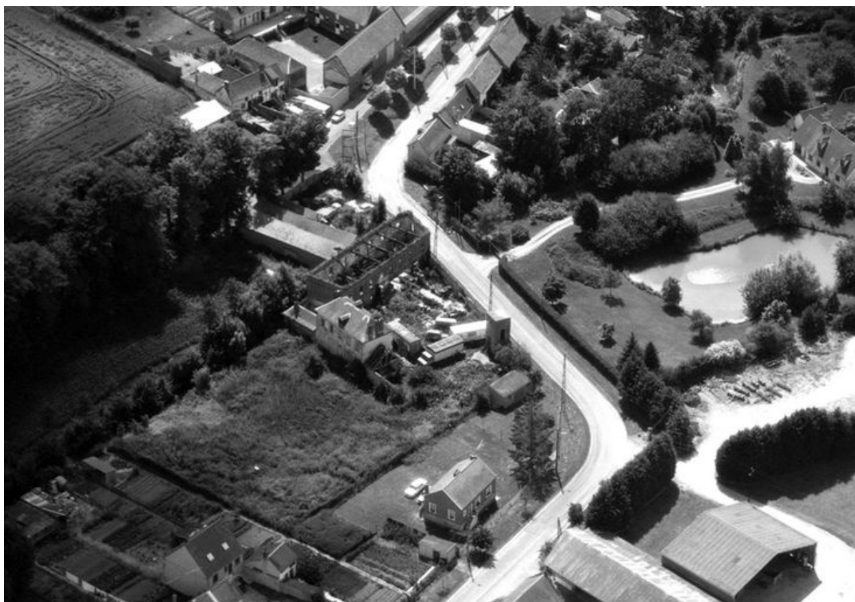
Vue aérienne, flanc nord-ouest.
