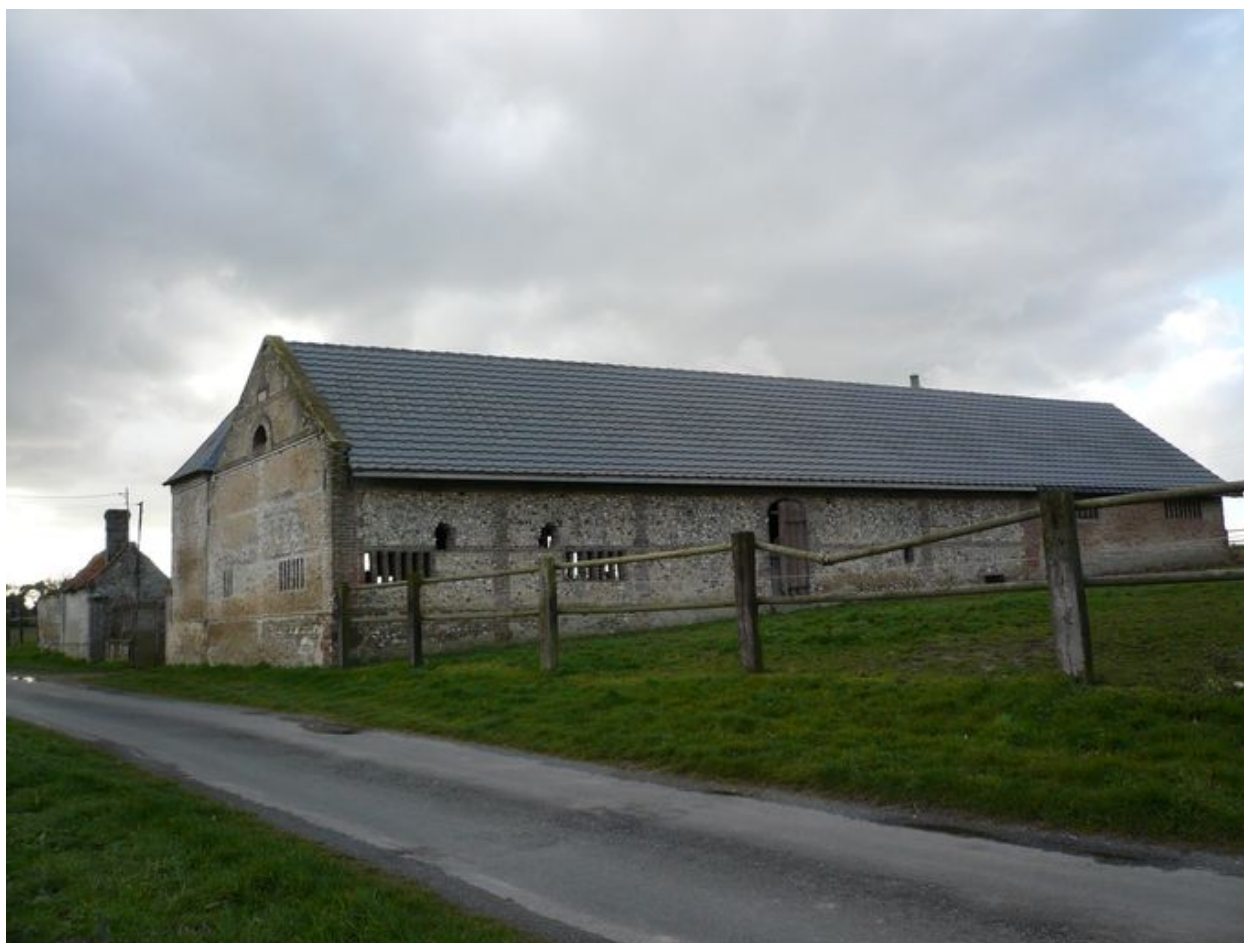
Vue postérieure des dépendances.
