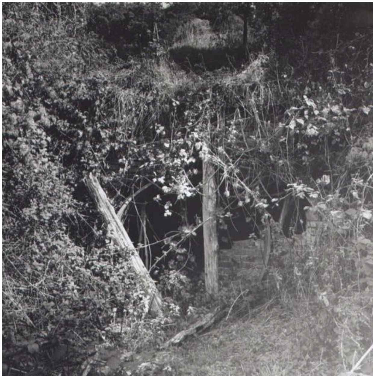
Entrée du four à chaux situé près de la carrière.
