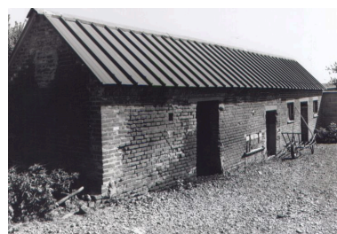
Les écuries et les étables de la briqueterie. Phot. Thierry Lefébure IVR22_20026000861X
