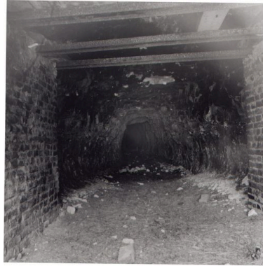
Intérieur de la galerie d'extraction dans la carrière de craie. Phot. Thierry Lefébure IVR22_20026000857X
