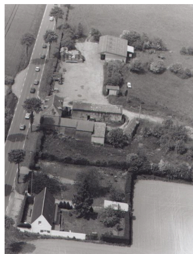
Vue aérienne de la briqueterie en 1994. Phot. Phot'R IVR22_19946001732X
