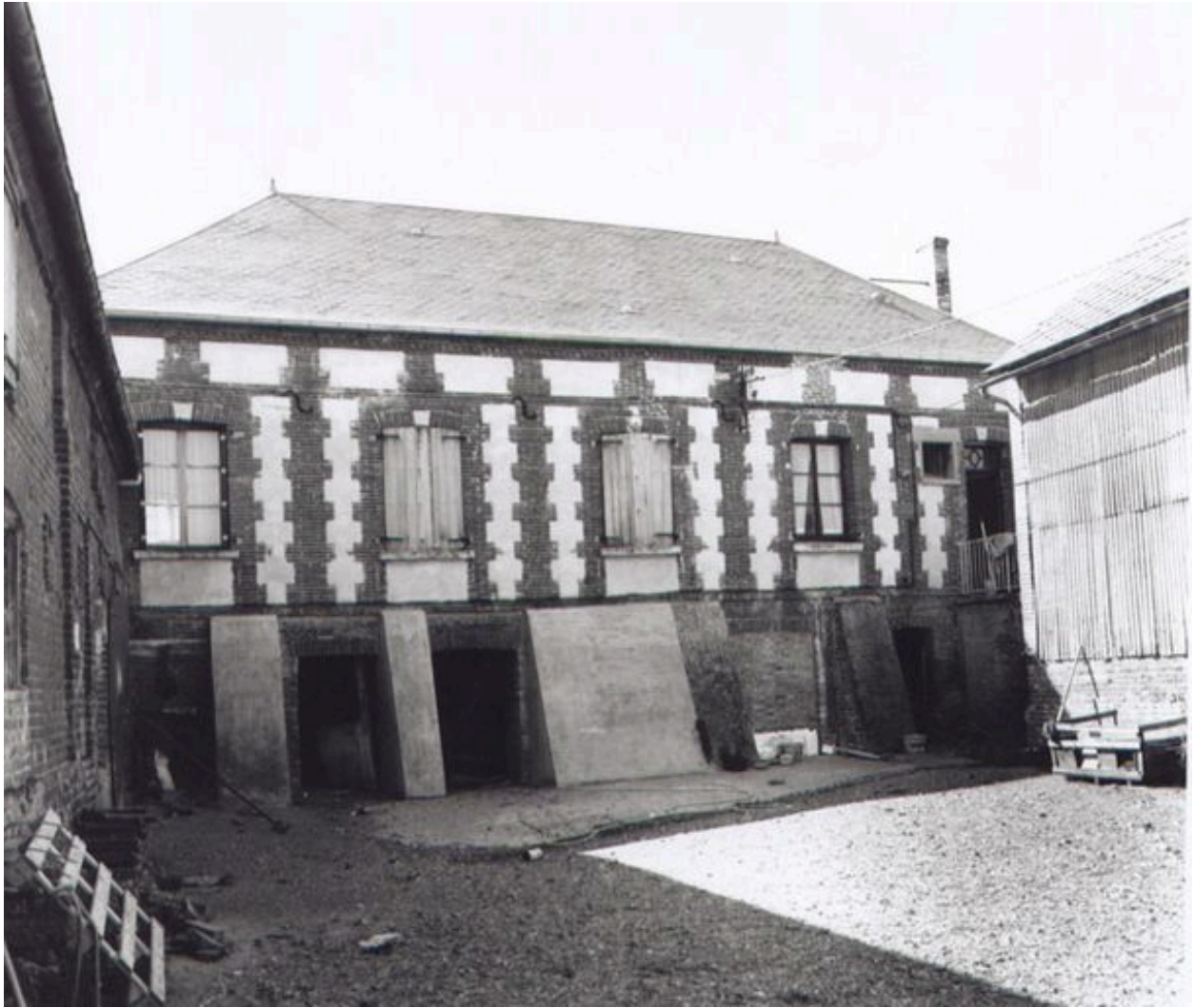
Le logement de briquetier, façade postérieure sur cour.
