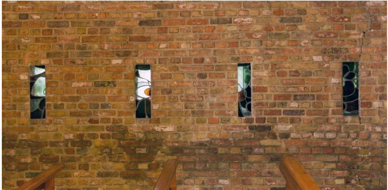
Vue des verrières côté droit.
