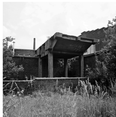
Support de cuve en béton armé sur le ruisseau du Crachet. Vue prise vers le nord. Phot. Philippe Dapvril IVR31_19885901189X
