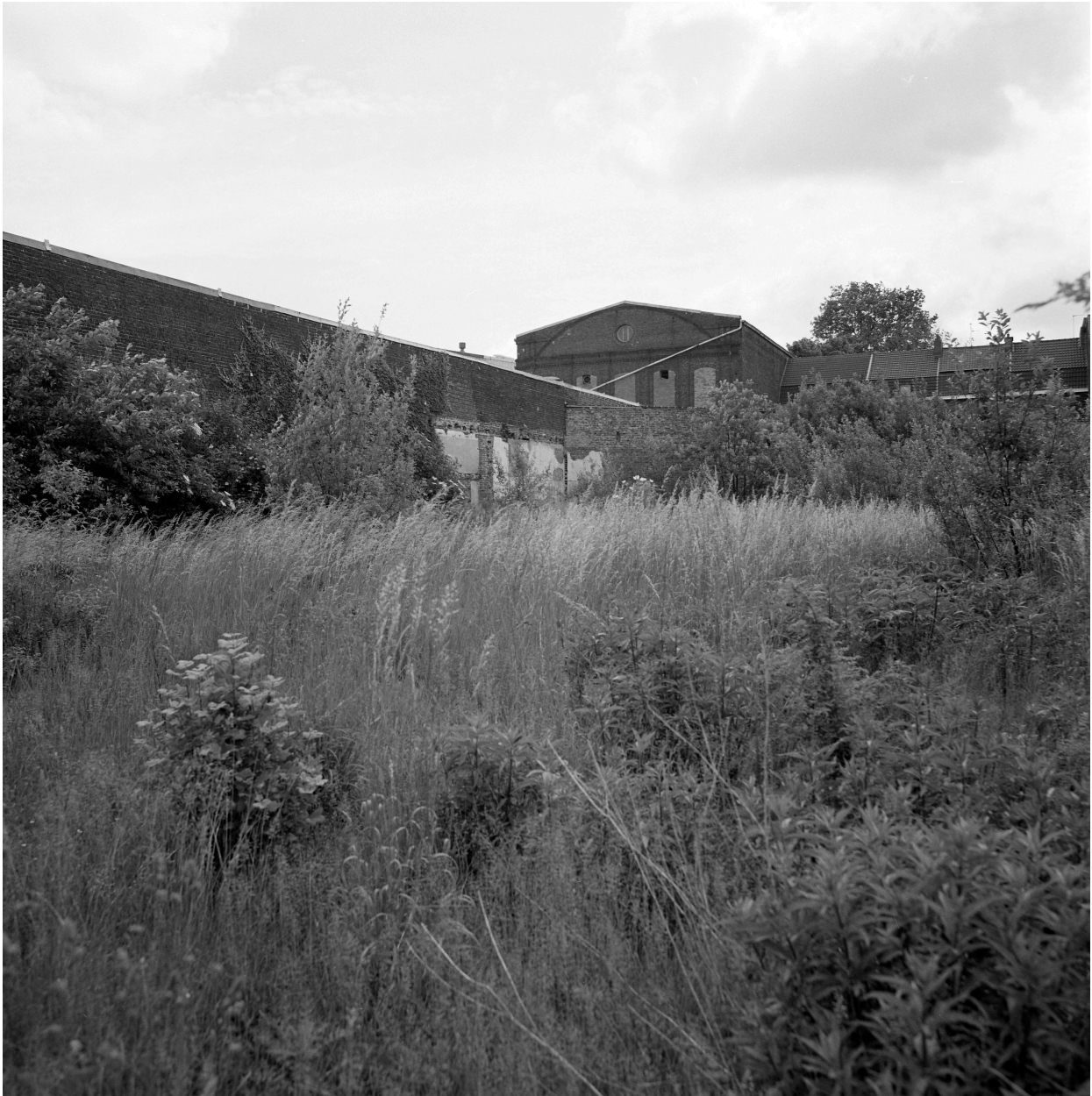
Atelier de fabrication. Vue prise vers le nord.
