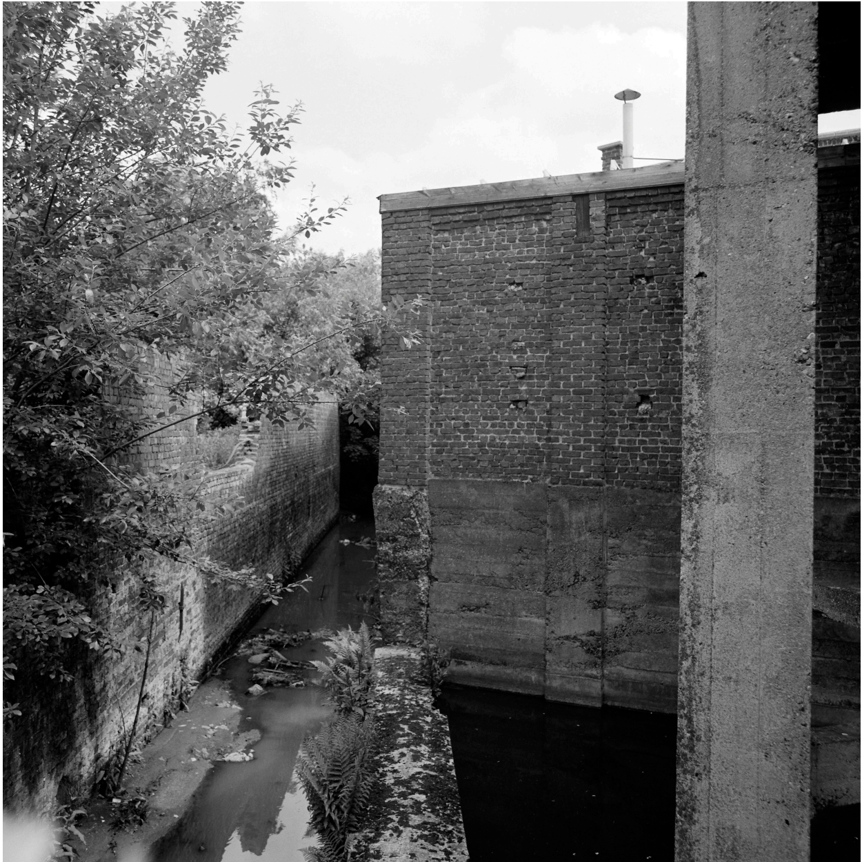
Murs d'enceinte sur le ruisseau du Crachet. Vue prise vers l'ouest.
