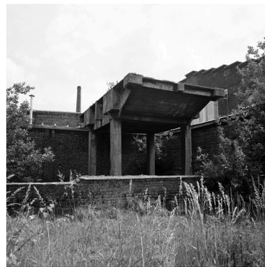
Support de cuve en béton
