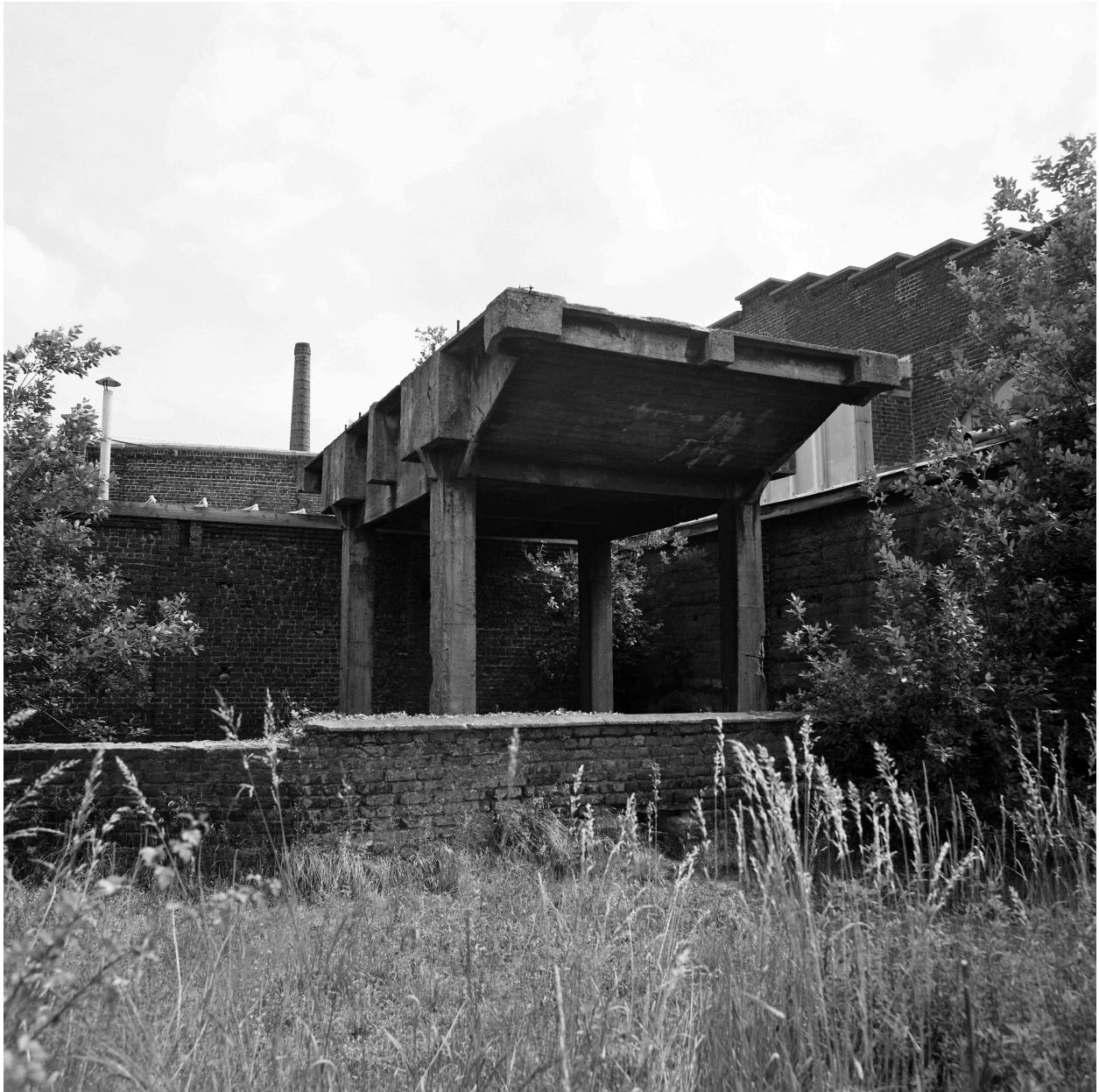
Support de cuve en béton armé sur le ruisseau du Crachet. Vue prise vers le nord.
