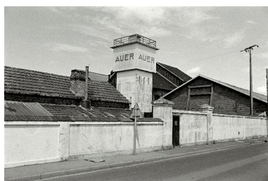
Le château d'eau depuis la rue Victor Hugo, en 1990. Phot. Francis Dubuc IVR22_19908000103Z
