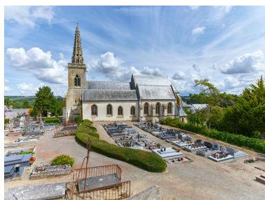
Vue sud du cimetière et de l'église. Phot. Thierry Lefébure IVR32_20238000328NUCA
