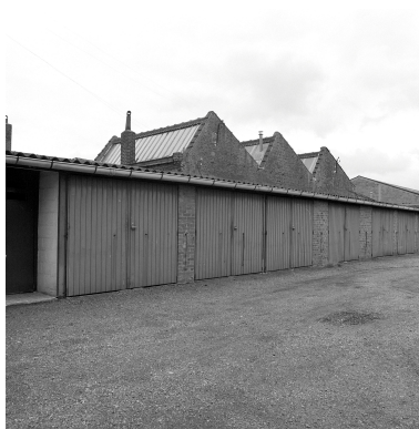
Atelier de fabrication. Phot. Philippe Dapvril IVR31_19885901237X
