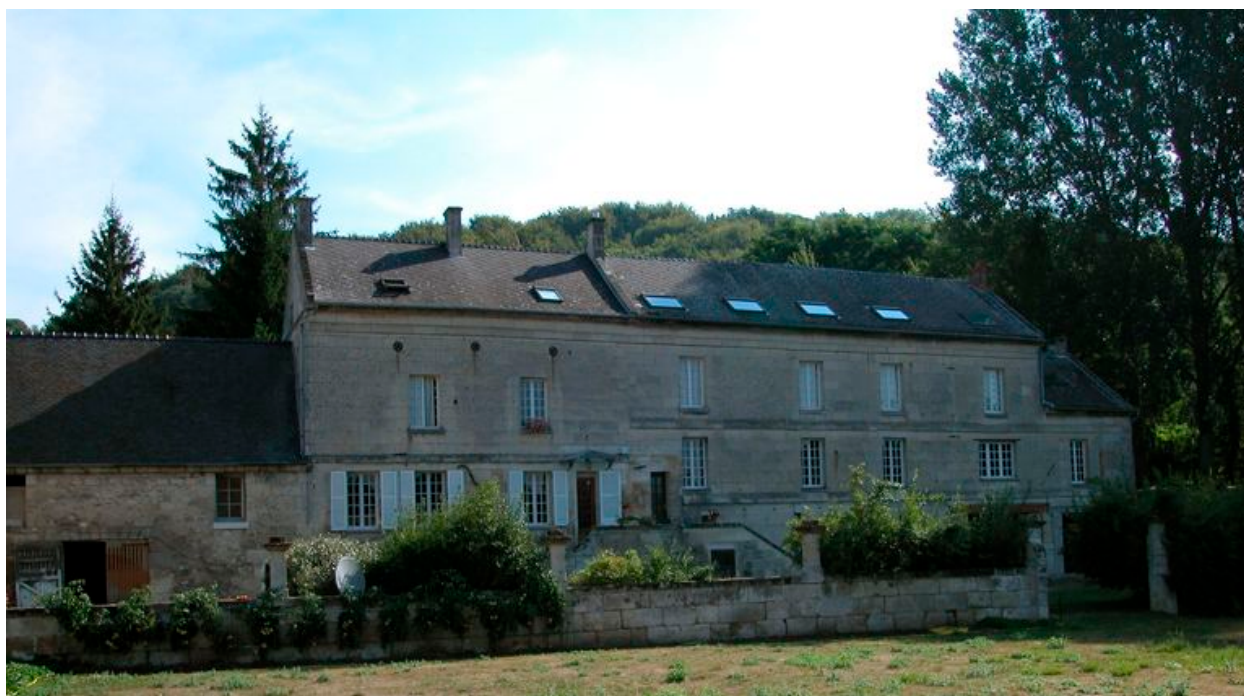
Vue de la façade postérieure
