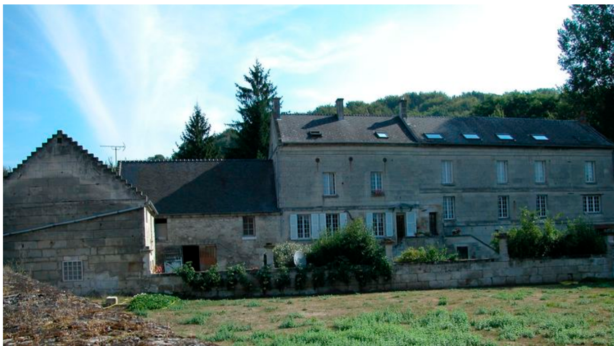
Vue de la façade postérieure avec la remise au premier plan
