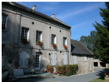
Vue de la façade antérieure du logis Phot. Bertrand Fournier IVR22_20030203399NUCA
