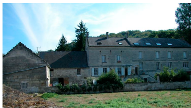
Vue de la façade postérieure avec la remise au premier plan Phot. Bertrand Fournier IVR22_20030203397NUCA
