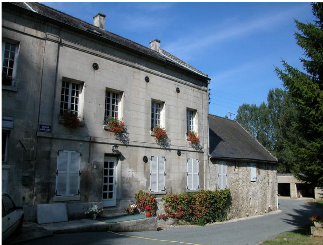
Vue de la façade antérieure du logis
