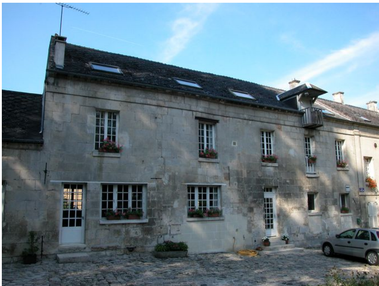
Vue de la façade antérieure du moulin
