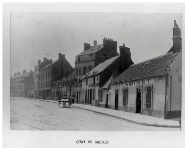
Vue d'angle, cliché. A.C. Boulogne-sur-Mer, clichés 1900. Repro. Éric Dessert IVR31_19806202146XB
