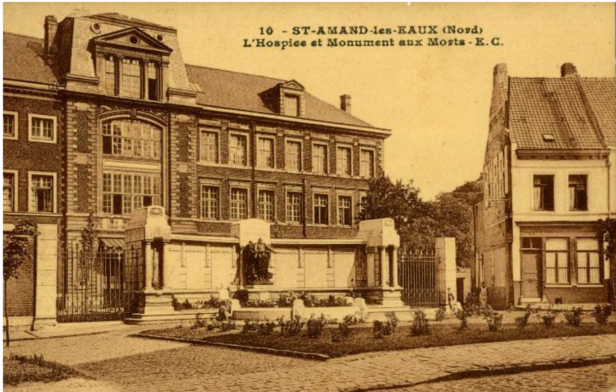
Le monument aux morts devant l'ancien hospice avant son déplacement, carte postale, 20e siècle (Médiathèque saint-Amand-les-Eaux).
