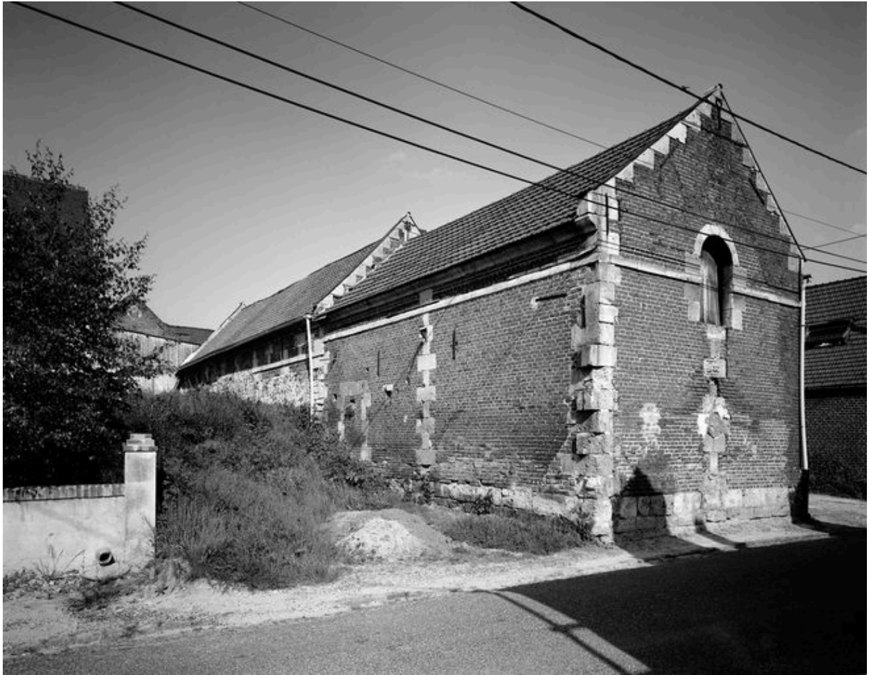
Vue générale postérieure.
