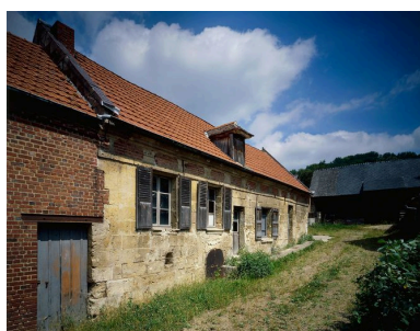
Logis. Elévation antérieure. Phot. Fabrice Charrondière IVR22_19866000161VA
