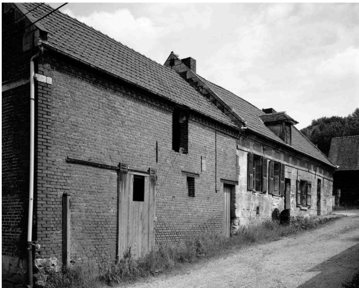
Etable à chevaux et logis. Vue générale.
