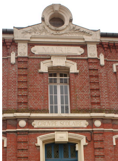
Détail sur la partie supérieure de la travée centrale.
