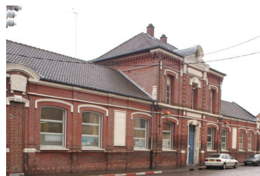
Vue générale depuis la rue. Phot. Thierry Lefébure IVR22_20038000526NUCA
