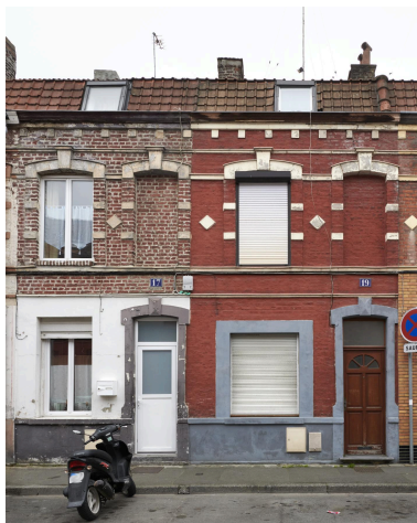
Vue générale des n°17-18 rue du Marquisat, briques et losanges sur la longueur des façades. Phot. Delphine Volto Jourdan IVR32_20265900117NUCA
