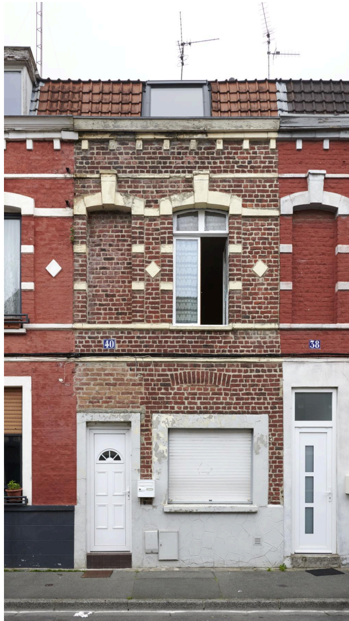
Vue générale du n°40, briques et losanges sur la longueur de sa façade.
