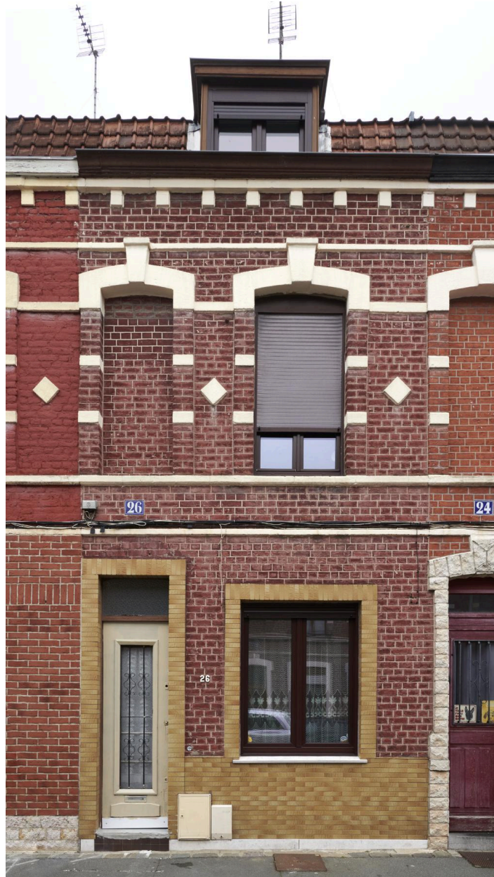
Vue générale du n°26, briques et losanges sur la longueur de sa façade.
