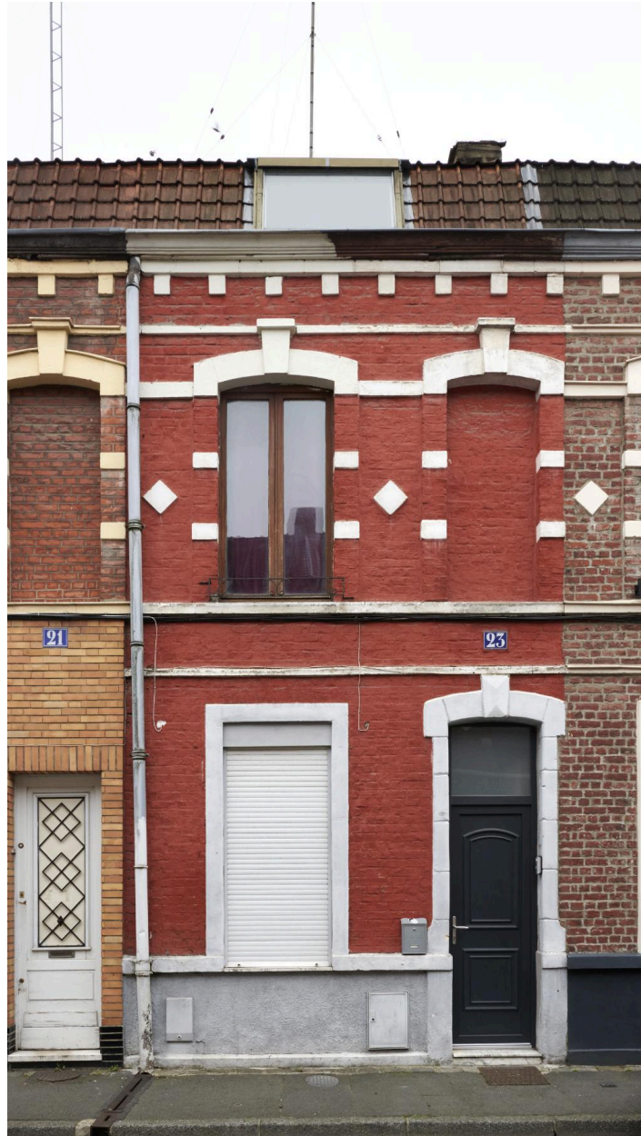
Vue générale du n°23 rue du Marquisat, briques et losanges sur la longueur de la façade et de ses voisines.
