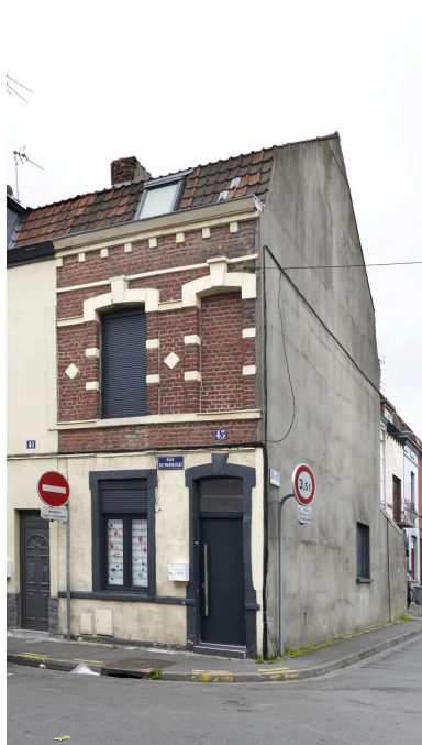
Vue générale de la façade au n°43, avec pignon, briques et losanges sur la longueur de sa façade. Phot. Delphine Volto Jourdan IVR32_20265900121NUCA
