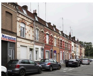
Vue générale du rang de maisons, côté sud. Phot. Delphine Volto Jourdan IVR32_20265900114NUCA
