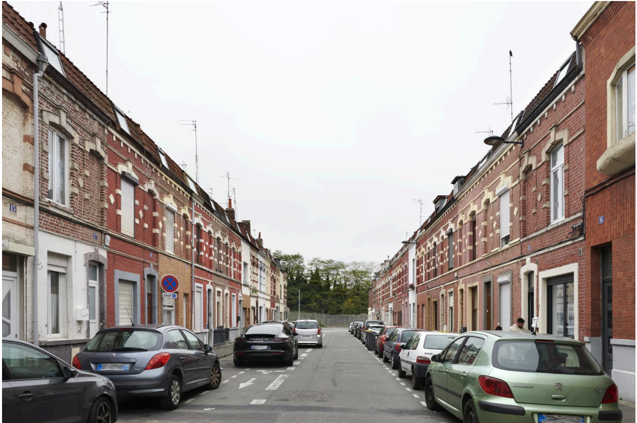
Vue générale des deux choques, rue du Marquisat.
