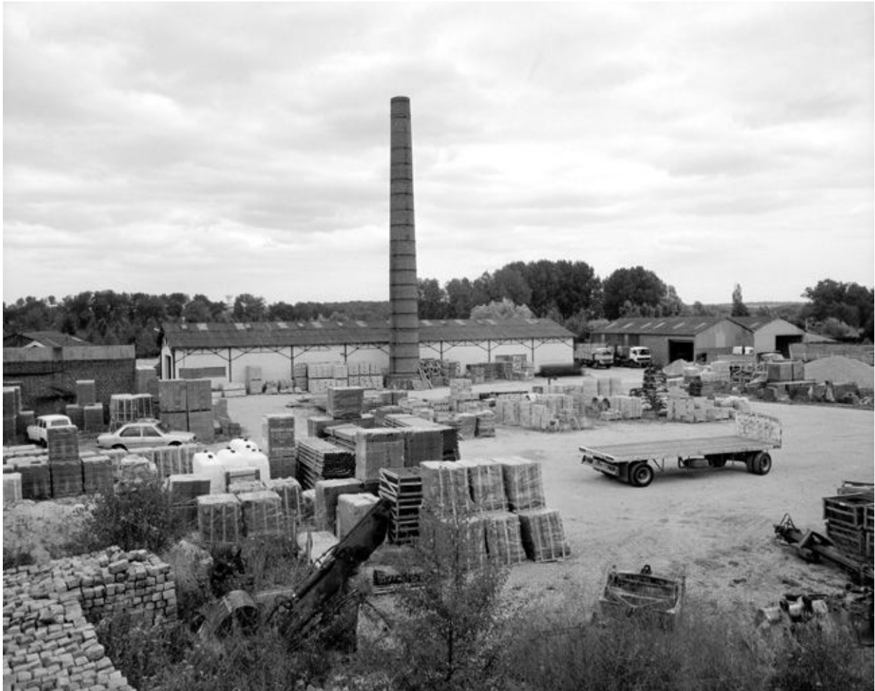
Vue de l'air de stockage, de la cheminée et du four.
