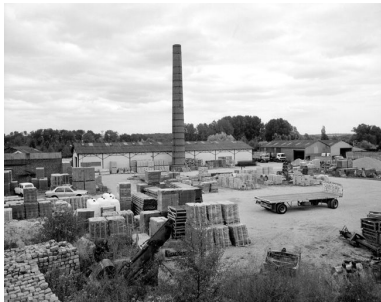
Vue de l'air de stockage, de la cheminée et du four. Phot. Thierry Lefébure IVR22_19898000336X
