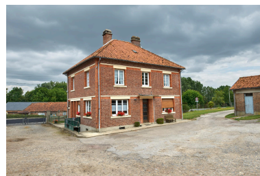
Maison d'habitation, vue prise depuis le sud-ouest. Phot. Thierry Lefébure IVR32_20238000471NUCA
