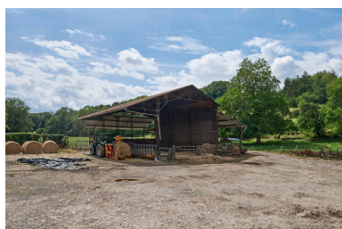
Hangar agricole, vue prise depuis le nord. Phot. Thierry Lefébure IVR32_20238000476NUCA
