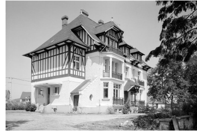
Nouveau château de Morlincourt (Oise). Phot. Jean-Michel Périn IVR22_19856000886X
