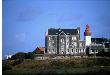
Les Moulinets, maison de villégiature devenue colonie de vacances, Ault (Somme). Phot. Marie-Laure Monnehay-Vulliet IVR22_20028000073ZA
