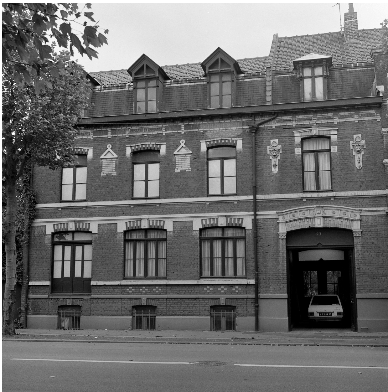
Les quatre travées sud de l'élévation antérieure, boulevard Faidherbe.
