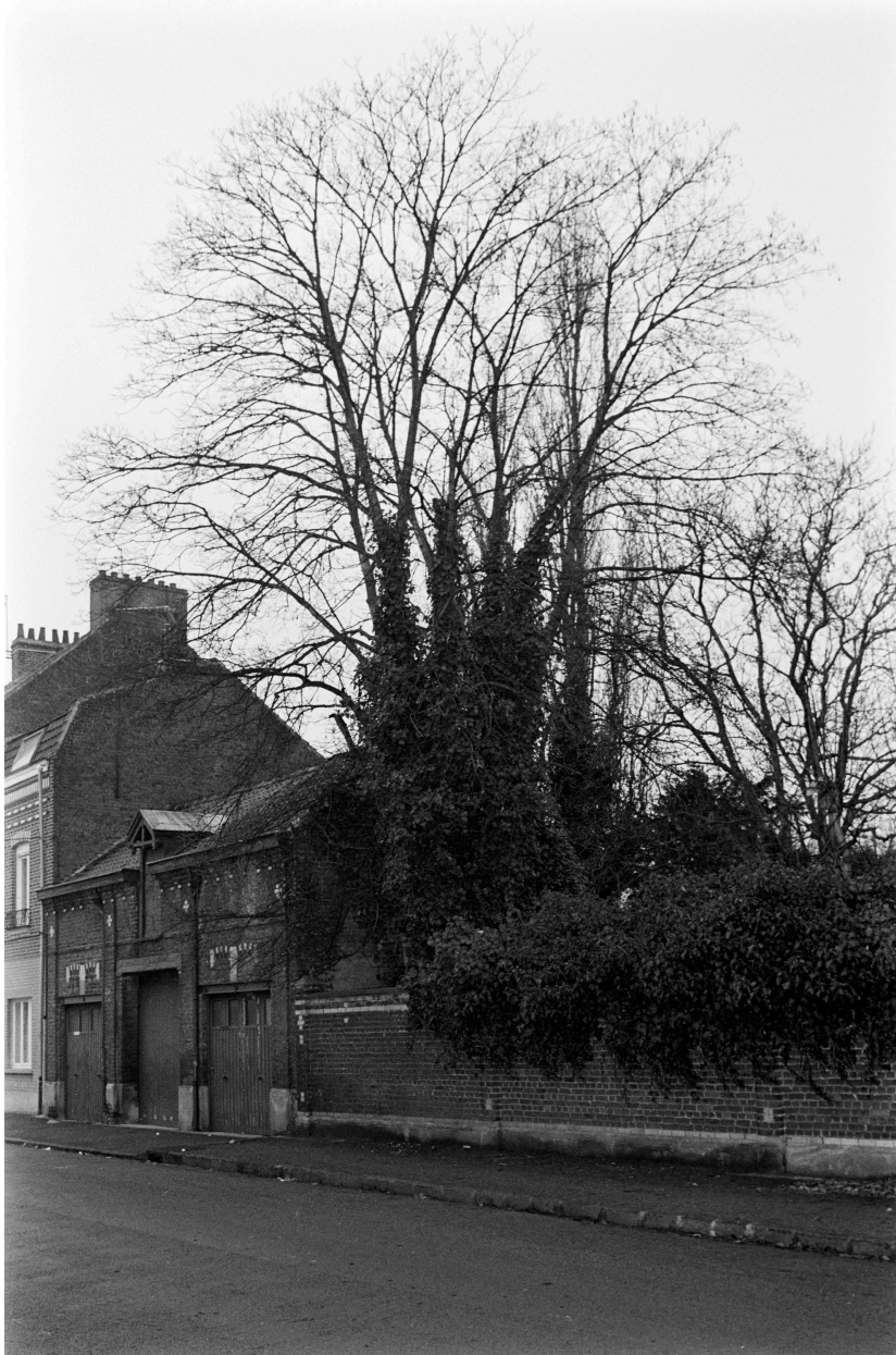
Remise, écuries (?) rue Colbert.
