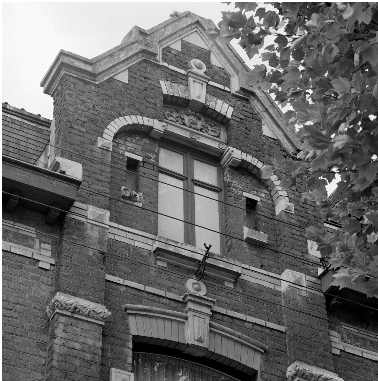
Lucarne-pignon de la cinquième travée sud de l'élévation antérieure.
