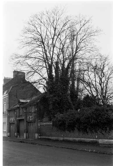
Remise, écuries (?) rue Colbert.
