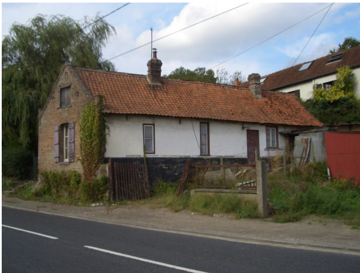
Vue de la façade orientale.
