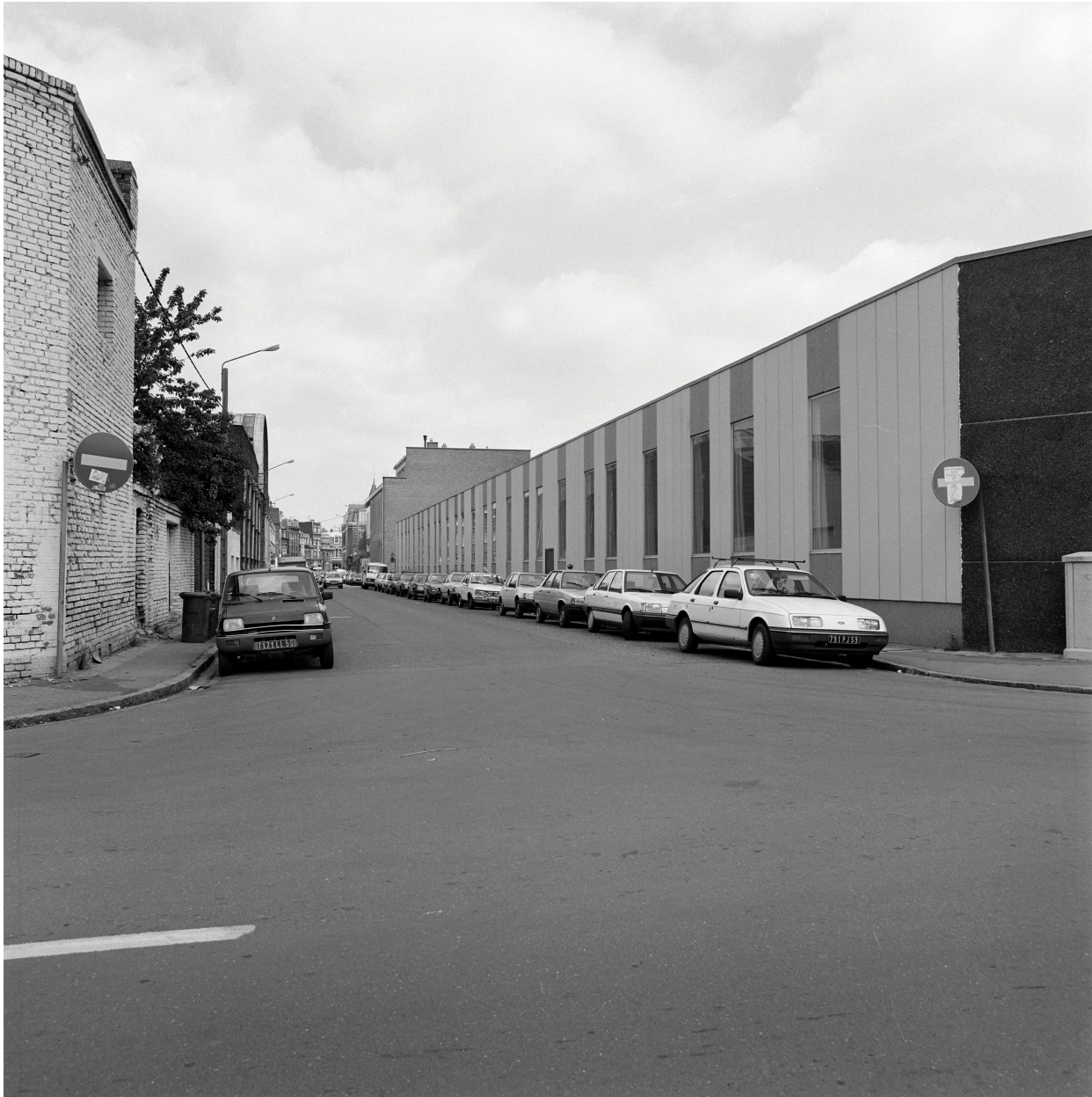
Elévation rue Hurtel. Vue prise vers le nord.
