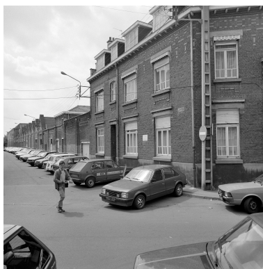
Élévation rue Hurtel. Vue générale prise vers le sud. Phot. Philippe Dapvril IVR31_19885900826X
