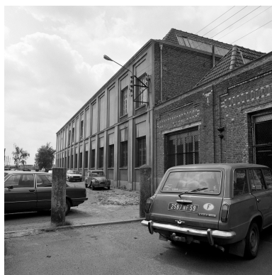
Atelier de fabrication. Phot. Philippe Dapvril IVR31_19885900825X
