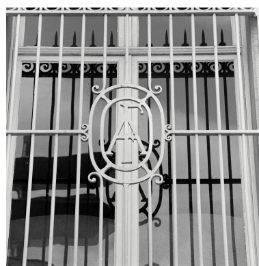
Élévation antérieure. Bureaux. Ferronnerie aux initiales de Agache et Fils. Phot. Philippe Dapvril IVR31_19885900828X
