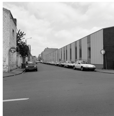
Élévation rue Hurtel. Vue prise vers le nord. Phot. Philippe Dapvril IVR31_19885900833X
