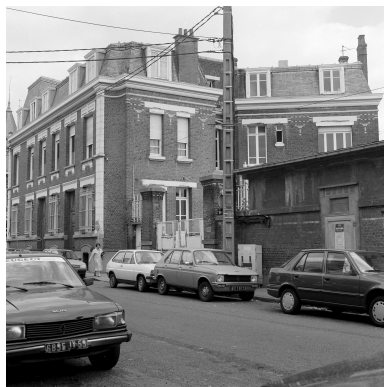
Élévation postérieure. Bureaux. Phot. Philippe Dapvril IVR31_19885900831X
