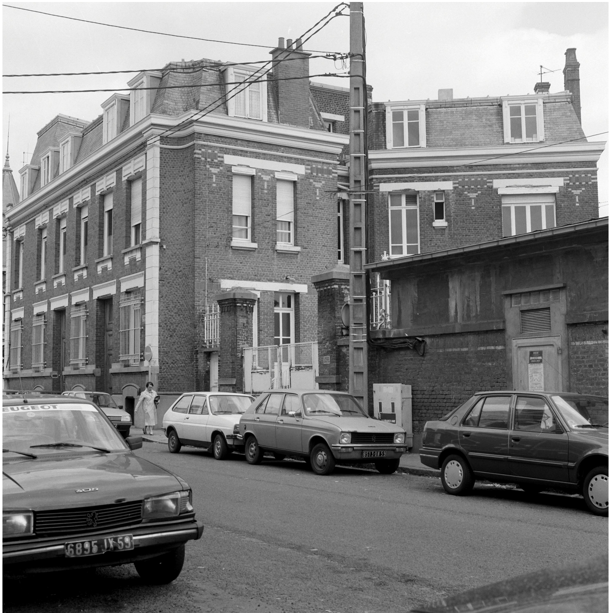
Élévation postérieure. Bureaux.
