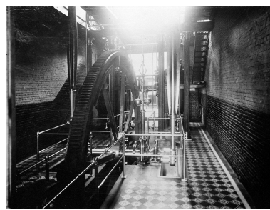
Salle des machines (II) des établissements Pouchain. Photographie, [ca 1897] (coll. part. Delepoulle). Repro. Olivier Marlard, Phot. auteur inconnu IVR31_19885902183X
