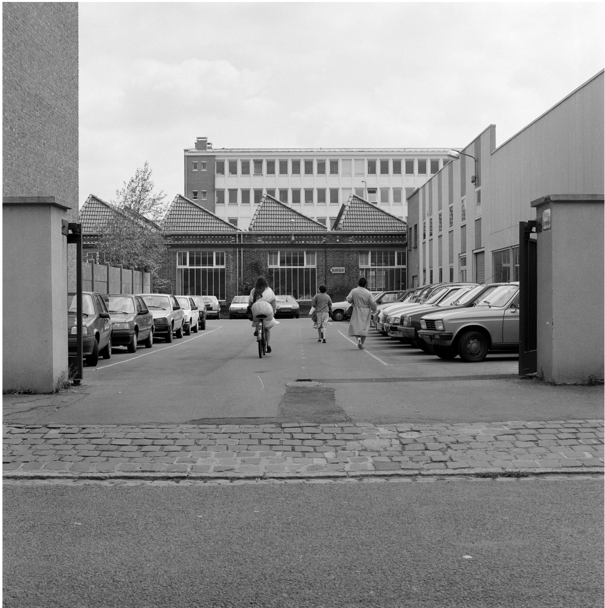
Atelier de fabrication. Vue prise vers l'est.
