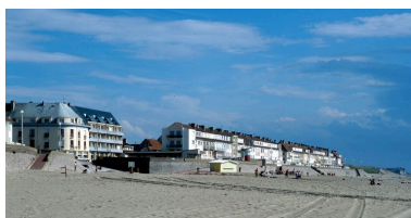
Le front de mer de Fort-Mahon-Plage : vue d'ensemble de la digue sud, depuis le nord. Phot. Marie-Laure Monnehay-Vulliet IVR22_20038000488XA
