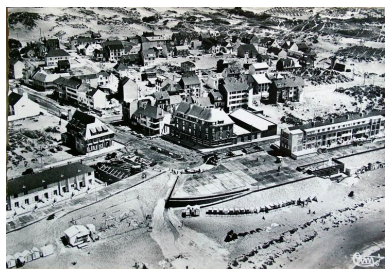
Vue aérienne du front de mer au débouché de l'avenue de la plage, carte postale, 3e quart 20e siècle (coll. part.). Phot. Monnehay-Vulliet Marie-Laure IVR22_20048000104NUCAB
