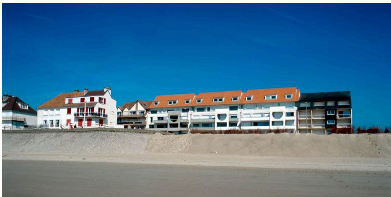
Le front de mer de Fort-Mahon-Plage : les nouveaux immeubles (début 21e siècle) dans le prolongement de la digue sud.
