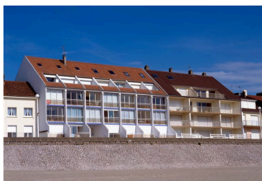
Le front de mer de Fort-Mahon-Plage : immeubles construits à la fin du 20e siècle sur la digue nord. Phot. Marie-Laure Monnehay-Vulliet IVR22_20038000497XA
