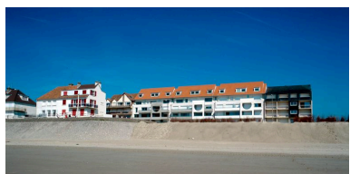
Le front de mer de Fort-Mahon-Plage : les nouveaux immeubles (début 21e siècle) dans le prolongement de la digue sud. Phot. Marie-Laure Monnehay-Vulliet IVR22_20038000487XA
