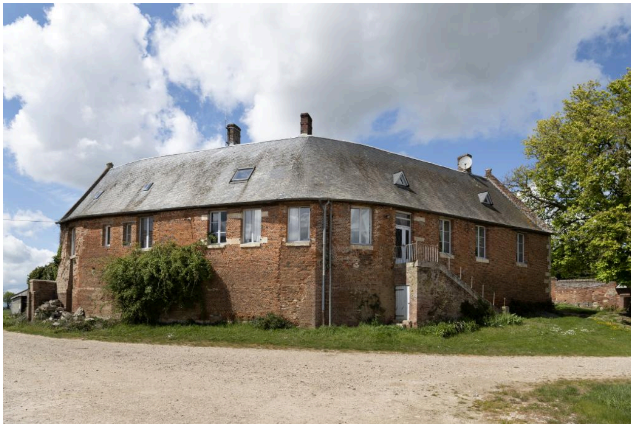
Logis reprenant la forme de l'ancien chemin de ronde de la forteresse médiévale, vue depuis le sud-est.
