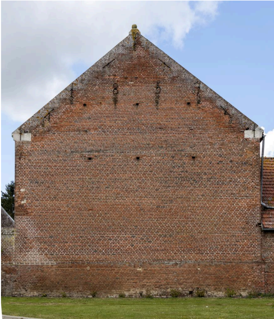
Pignon de la grange portant la date de 1856, vue depuis l'est.
