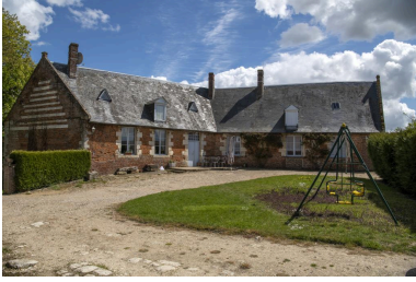
Logis (17e siècle?), vue depuis le nord-ouest. Phot. Marc Kérignard IVR32_20216000423NUCA
