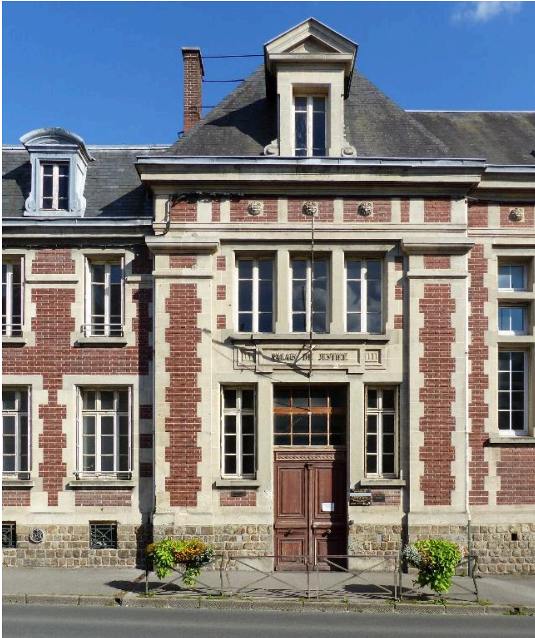
Vue de détail sur la travée d'accès du tribunal administratif.
