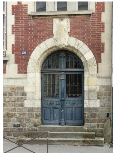
Porte avec remploi du gable de l'ancien bailliage de Péronne. Phot. Isabelle Barbedor IVR32_20228005105NUCA
