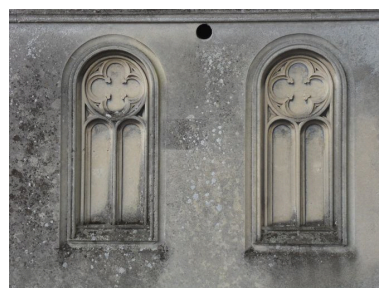
Vue de détail des baies aveugles du mur sud. Phot. Isabelle Barbedor IVR22_20118010025NUCA
