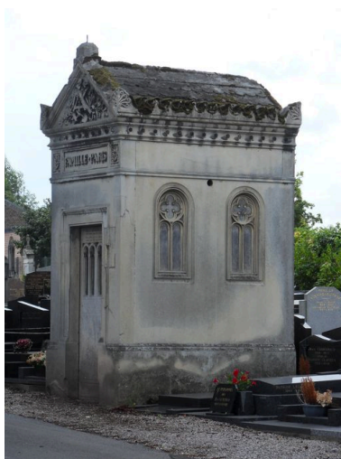
Vue générale de trois-quarts. Phot. Isabelle Barbedor IVR22_20098010005NUCA
