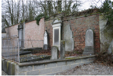
Vue latérale. Phot. Caroline Vincent IVR22_20068000627NUCA
