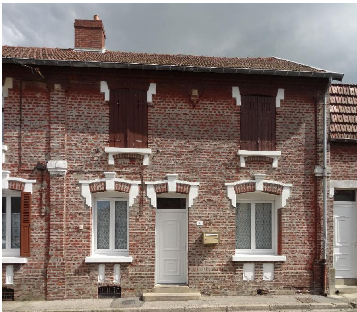
Vue d'un logement.
