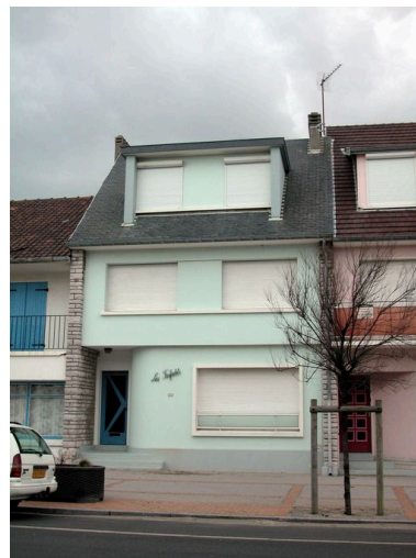
Vue d'ensemble depuis l'avenue de la Plage. Phot. Elisabeth Justome IVR22_20048001463NUCA
