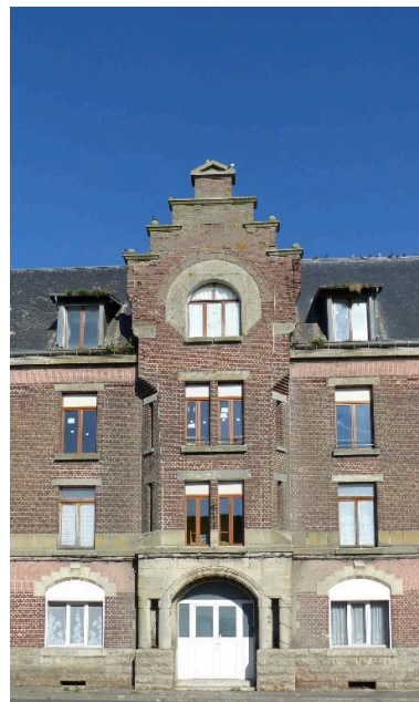
Vue de détail sur la travée centrale de la façade principale. Phot. Isabelle Barbedor IVR32_20168006285NUCA
