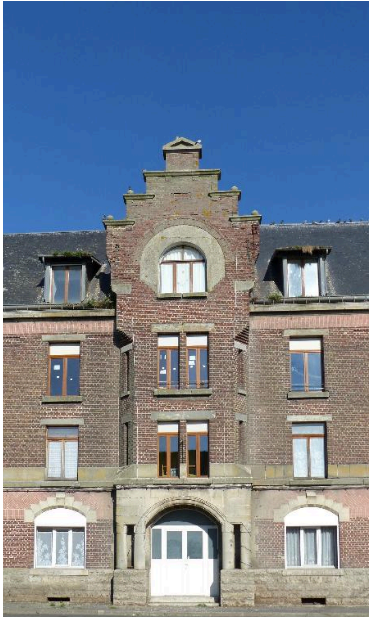
Vue de détail sur la travée centrale de la façade principale.
