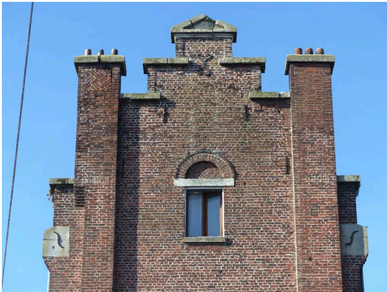
Vue du pignon est.
