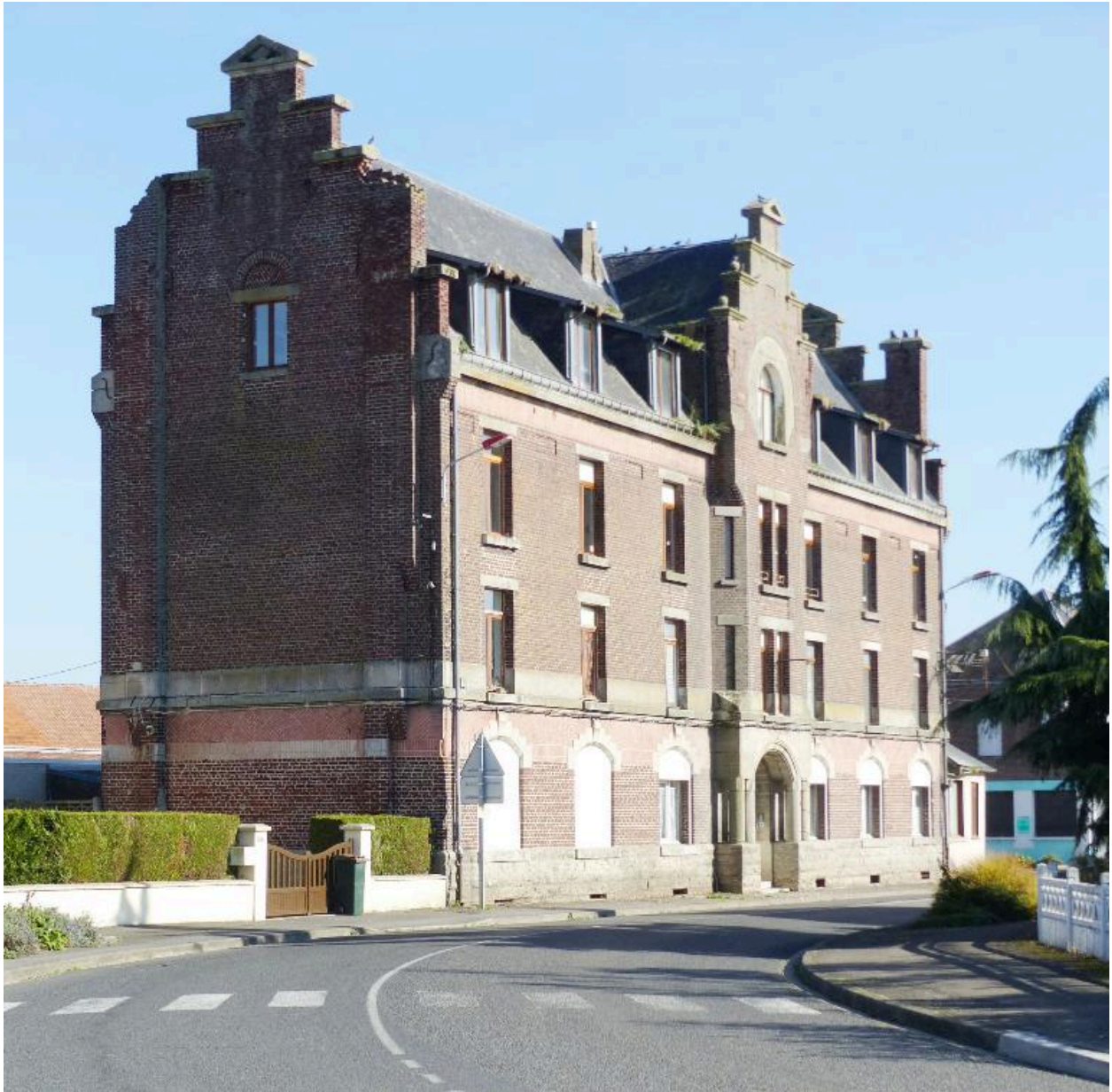
Vue générale, depuis le sud-ouest.
