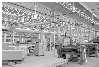
Atelier de fabrication, vue intérieure. Phot. Francis Dubuc IVR22_19908001231Z
