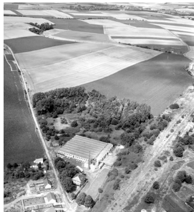
Vue aérienne, flanc sud. Phot. Phot'R IVR22_19888001287P
