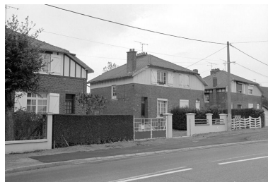
Logement d'ouvriers, vue d'ensemble. Phot. Francis Dubuc IVR22_19908001235Z
