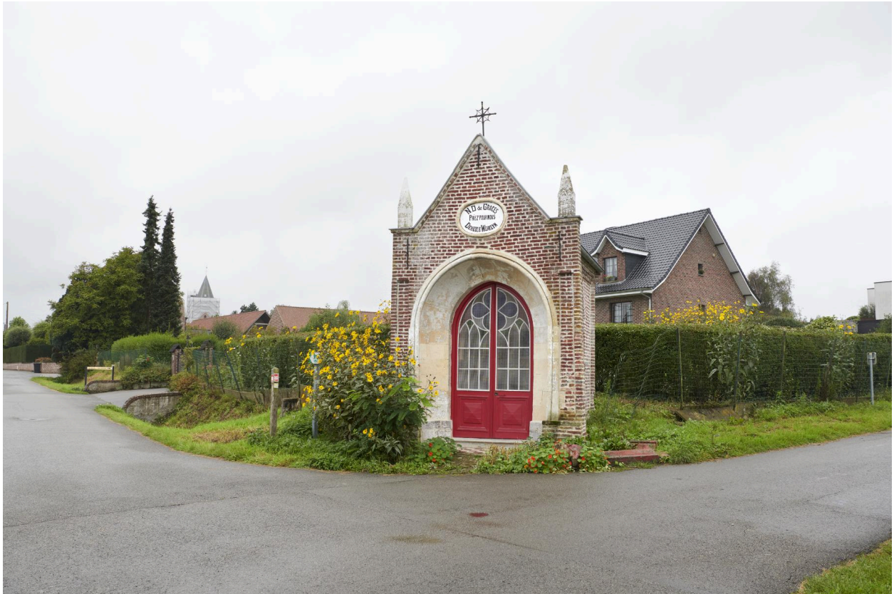
Chapelle dans son environnement de proximité.
