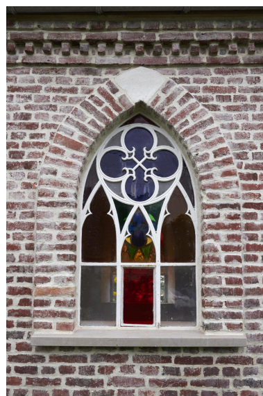
Détail d'une baie. Phot. Delphine Volto Jourdan IVR32_20245903187NUCA
