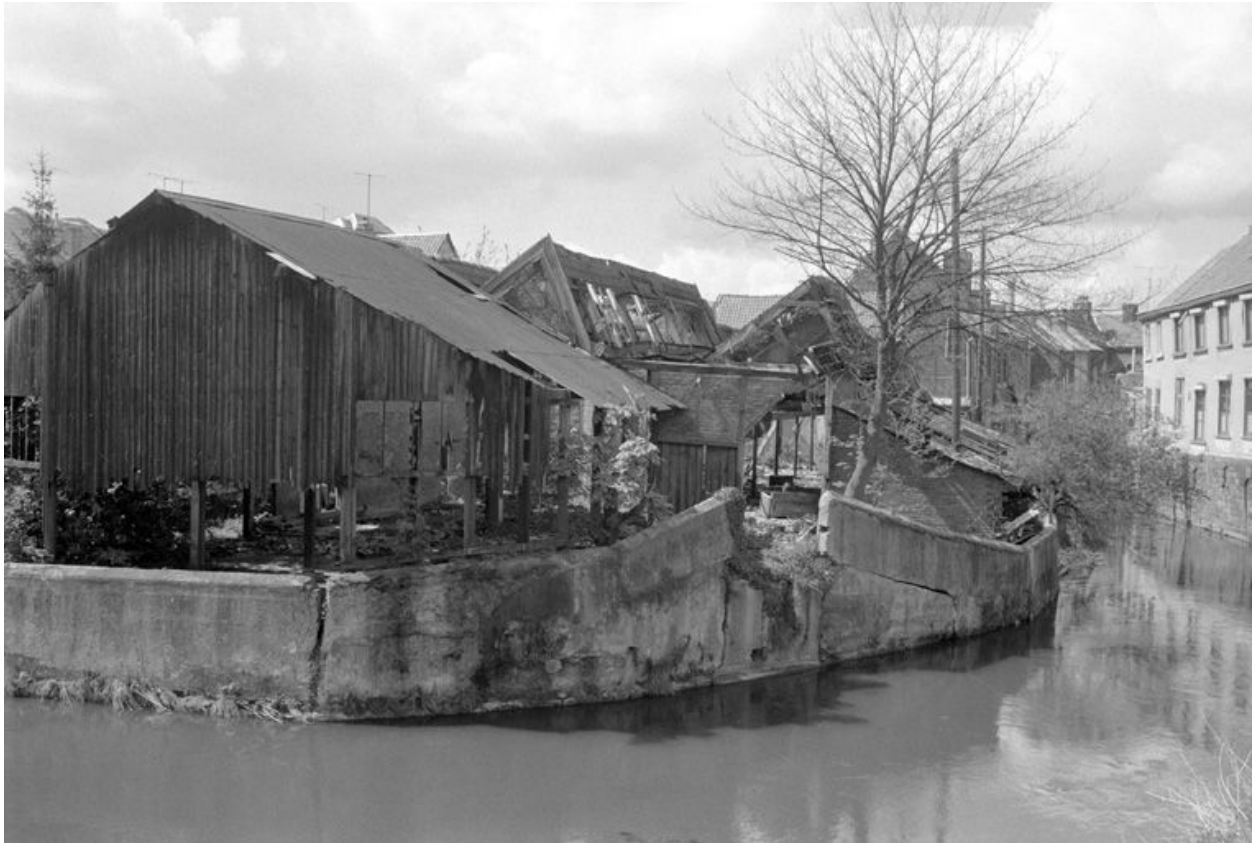
Vue générale de l'usine.
