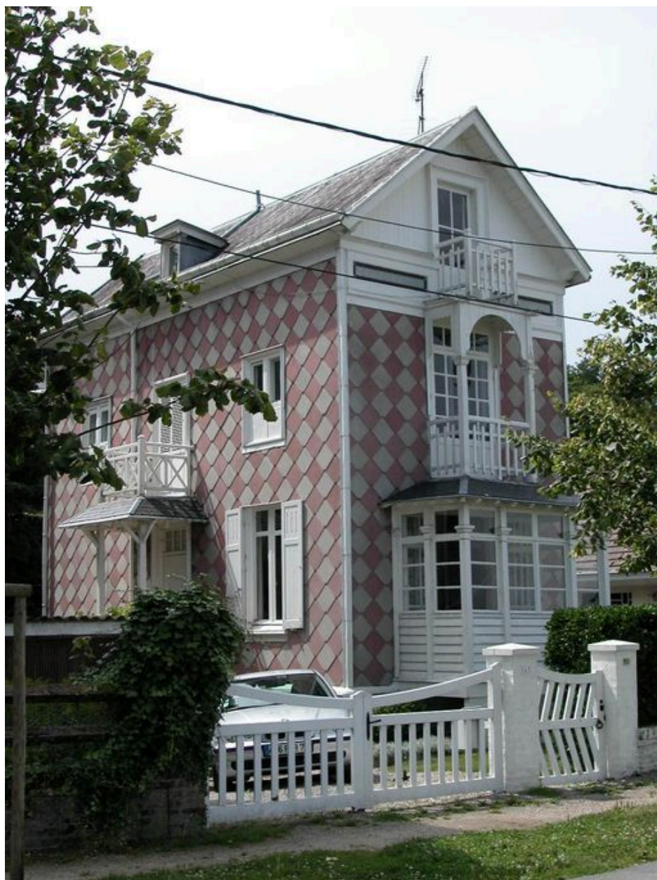
Vue d'ensemble depuis la digue.
