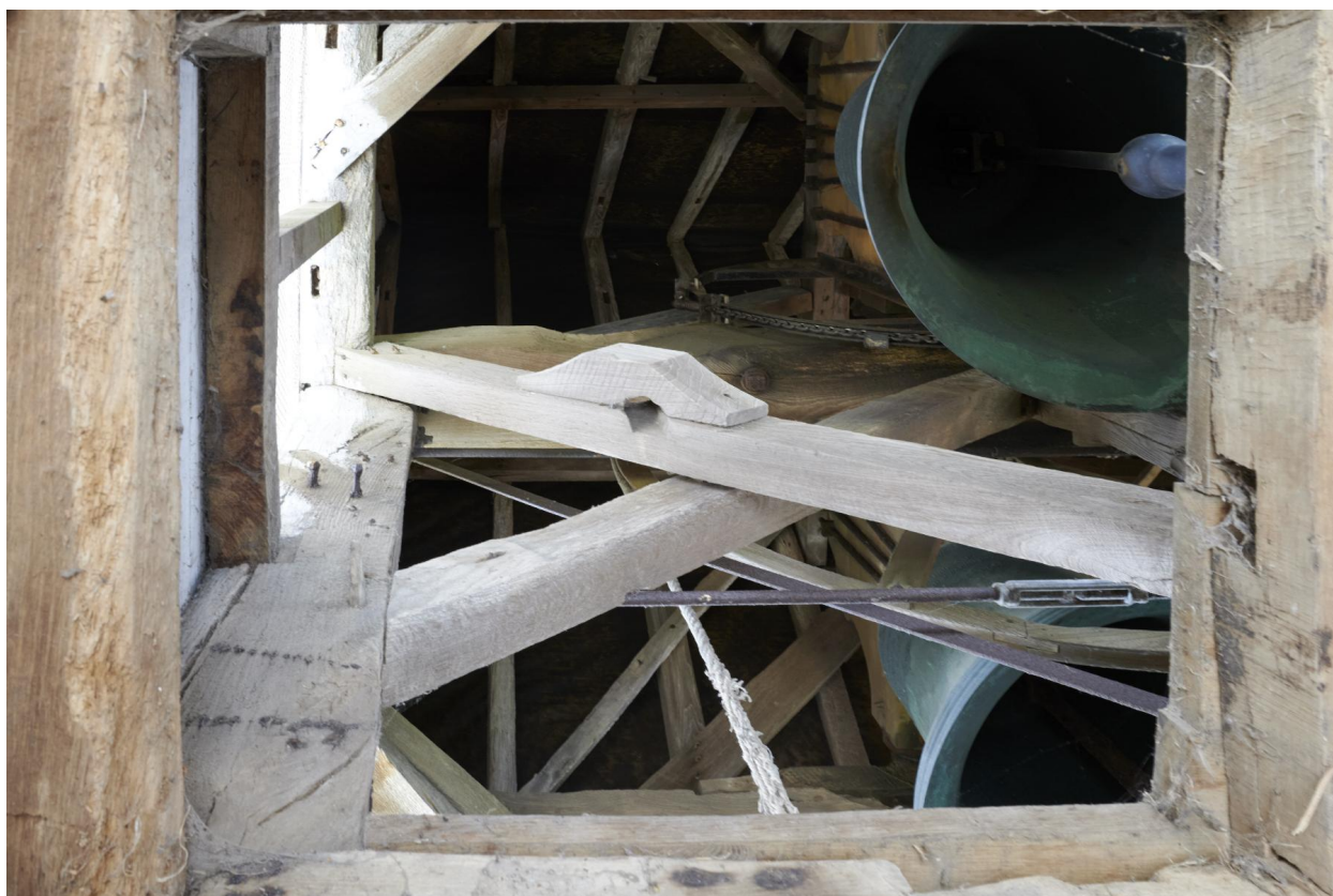
Vue intérieure de la Maison des cloches, charpente, mécanisme et les deux cloches.
