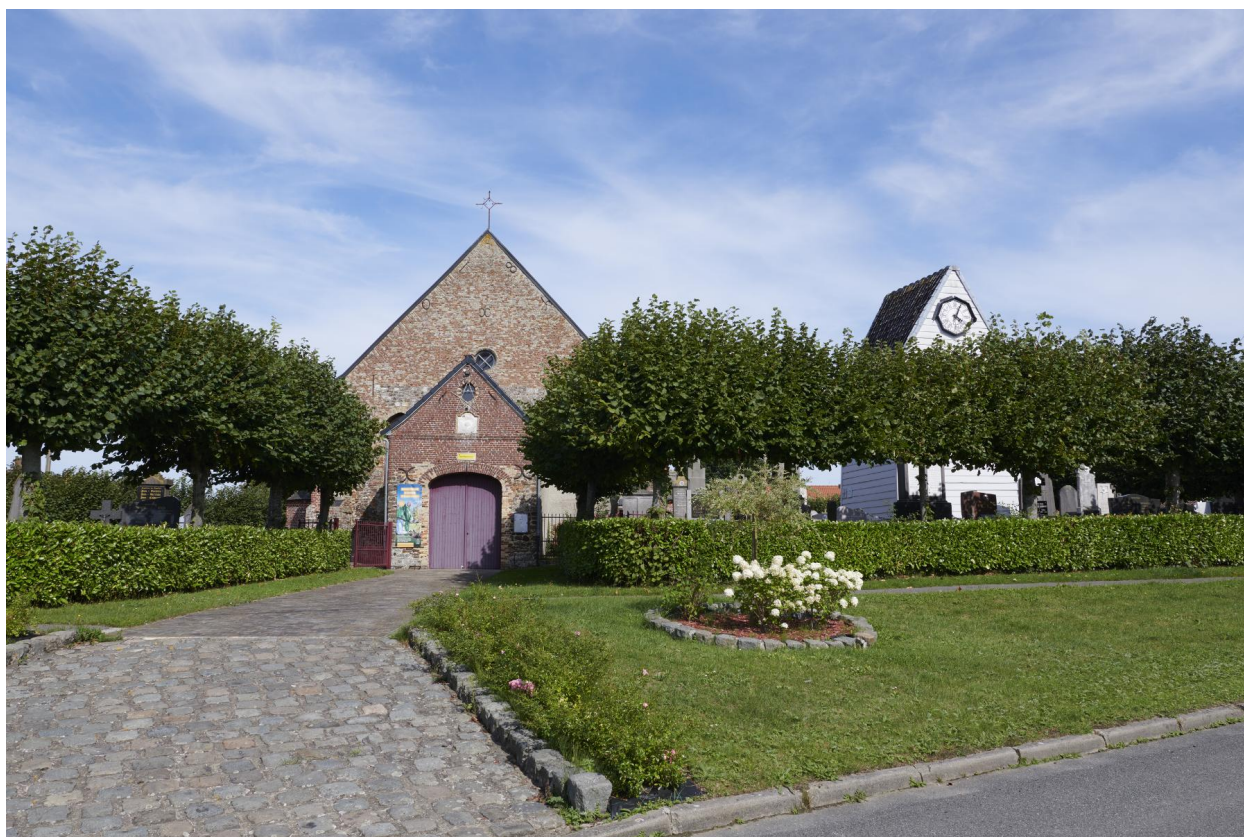
La maison des cloches dans son contexte, à l'abri d'une clôture végétale au sein du cimetière.
