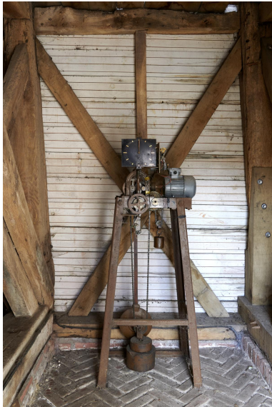
Ancien mécanisme d'horloge déposé au sol de la Maison des cloches. Phot. Delphine Volto-Jourdan IVR32_20245901923NUCA
