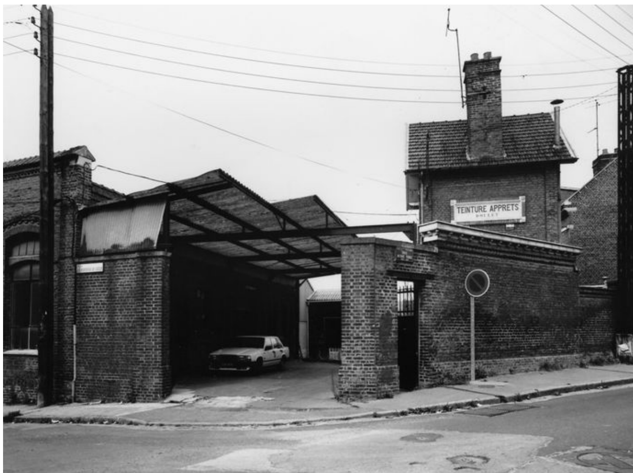
La conciergerie et l'entrée de l'usine.
