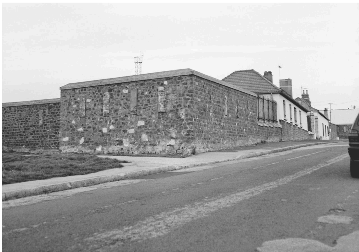
Vue d' angle sud est.
