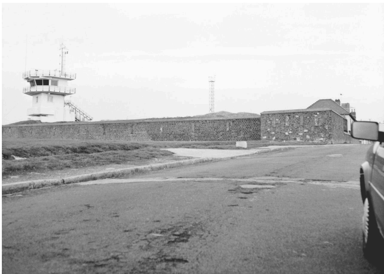
Façade partielle ouest.
