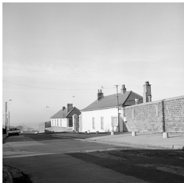
Vue générale sur entrée. Phot. Michèle Rougier IVR31_19966200749X
