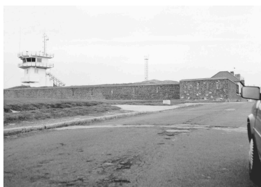
Façade partielle ouest. Phot. Michèle Rougier IVR31_19966200707X
