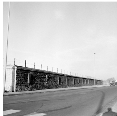
Façade rue d'Ambleteuse. Phot. Michèle Rougier IVR22_19966200013X
