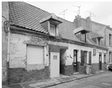
Rue Neuve, vue générale de la série des maisons n° 63 à 69, avec le passage portant le n° 65 (état en 2000).
