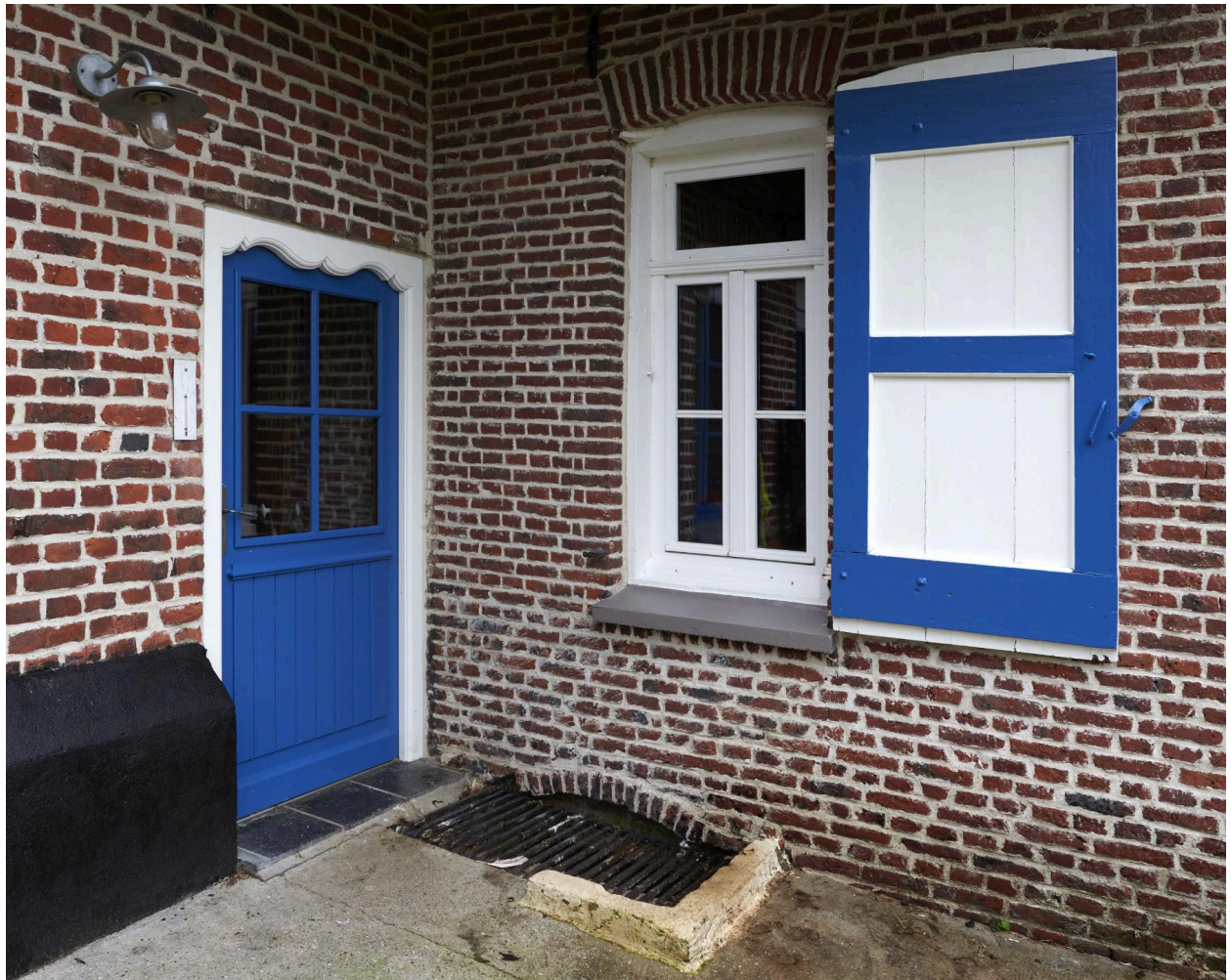
Porte secondaire et baie.
