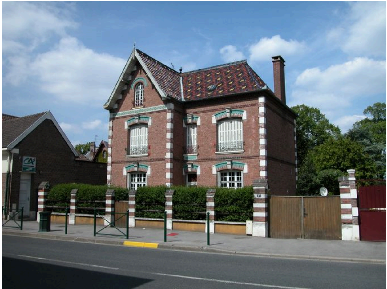
Vue d'ensemble depuis le quai du Romerel.
