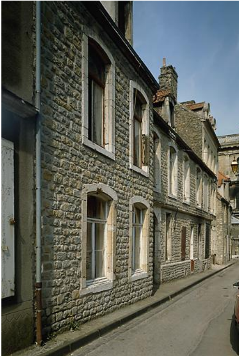
Façade sur voie après restauration.
