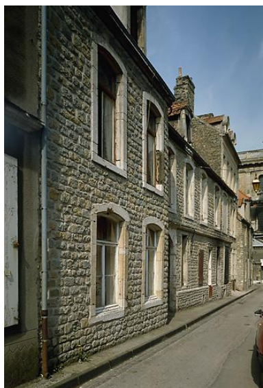
Façade sur voie après restauration. Phot. Jean-Michel Périn IVR31_19876201444XA
