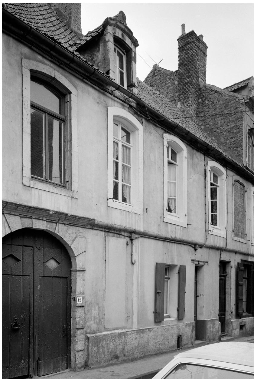
Façade partielle sur voie avant restauration.
