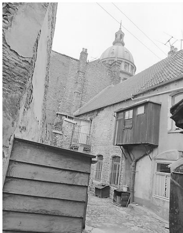
Façade sur cour. Phot. Jean-Michel Périn, Phot. Éric Dessert IVR31_19806203283X
