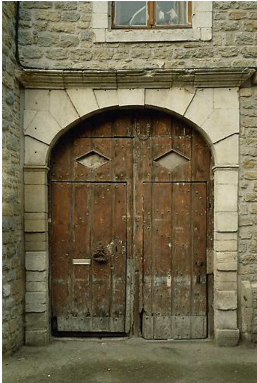
Façade sur voie, porte d'entrée : détail.
