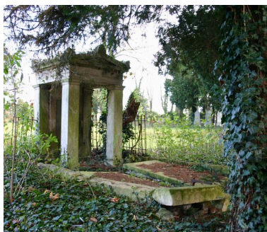
Vue générale, depuis le côté.
