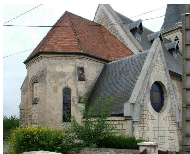
Vue du chevet, depuis le nord-est. Phot. Frédéric Fournis IVR22_20040202728NUC1A
