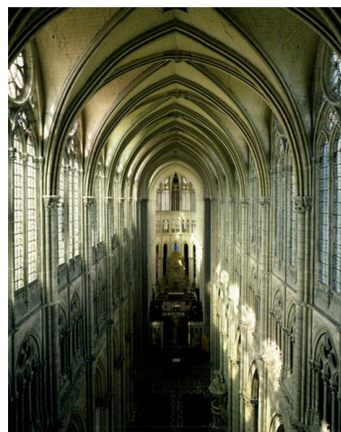
Vue intérieure vers le chœur. Phot. Fabrice Charrondière IVR22_19868000048VA
