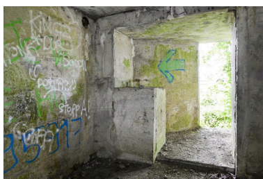
Salle nord. Vue vers l'entrée. Phot. Jean-Marc Ramette IVR31_20146203090NUCA
