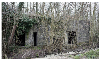
Elévation ouest : A gauche les deux entrées de la salle sud, à droite l'entrée de la salle nord. Au premier plan le ruisseau dit courant Brogniart Phot. Pierre Thibaut IVR31_20156200093NUCA
