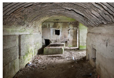
Vue générale de la salle sud, vers le nord Phot. Jean-Marc Ramette IVR31_20146203086NUCA
