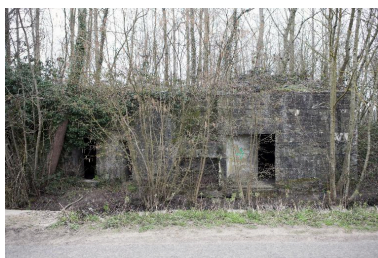
Elévation ouest : A gauche les deux entrées de la salle sud, à droite l'entrée de la salle nord. Au premier plan le ruisseau dit courant Brogniart Phot. Pierre Thibaut IVR31_20156200094NUCA
