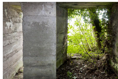
Salle sud, vers les deux entrées Phot. Jean-Marc Ramette IVR31_20146203078NUCA
