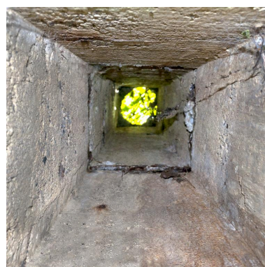
Salle sud : la cheminée en vue zénithale Phot. Jean-Marc Ramette IVR31_20146203082NUCA
