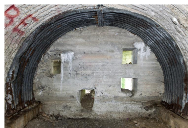
Depuis la salle nord : Orifices communicant avec la salle sud Phot. Jean-Marc Ramette IVR31_20146203089NUCA
