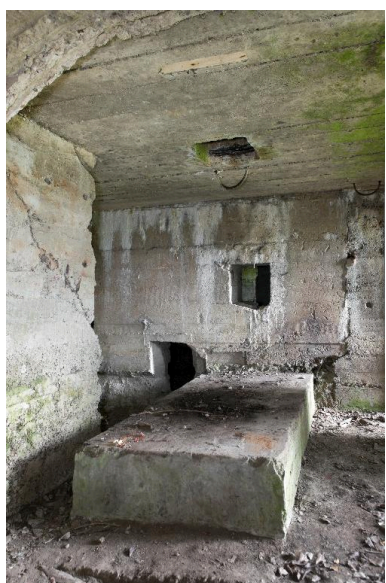
Salle sud : Massif bétonné du moteur diesel. Au fond, deux des quatre ouvertures débouchant salle nord (passage de tuyaux ?). On remarque les anneaux métalliques au plafond et la cheminée d'évacuation des fumées Phot. Jean-Marc Ramette IVR31_20146203087NUCA
