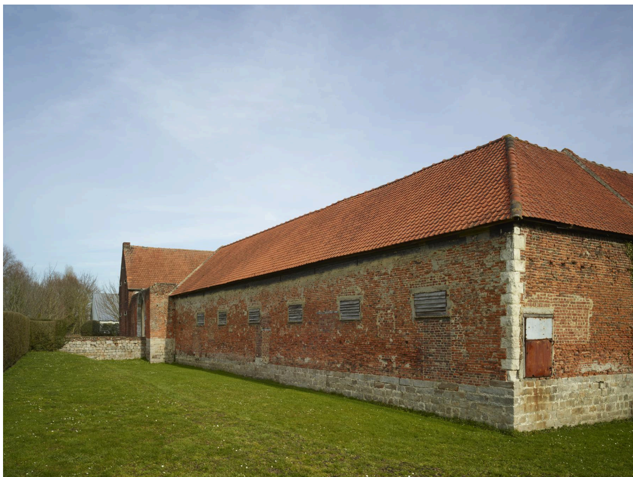
Bâtiment agricole situé à droite de l'entrée charretière. Vue prise depuis la rue.
