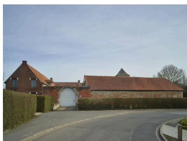
Façade sur rue. Entrée charretière et logis sur la gauche. Phot. Pierre Thibaut IVR32_20236200092NUCA
