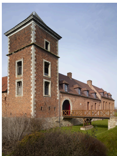
Angle sud-est de la ferme. Tour d'angle et seconde entrée charretière. Phot. Pierre Thibaut IVR32_20236200099NUCA
