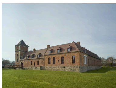
Angle nord-est de la ferme. Phot. Pierre Thibaut IVR32_20236200102NUCA
