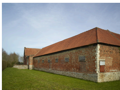
Bâtiment agricole situé à droite de l'entrée charretière. Vue prise depuis la rue. Phot. Pierre Thibaut IVR32_20236200096NUCA
