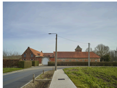
Façade sur rue. Entrée charretière et logis sur la gauche. Phot. Pierre Thibaut IVR32_20236200093NUCA
