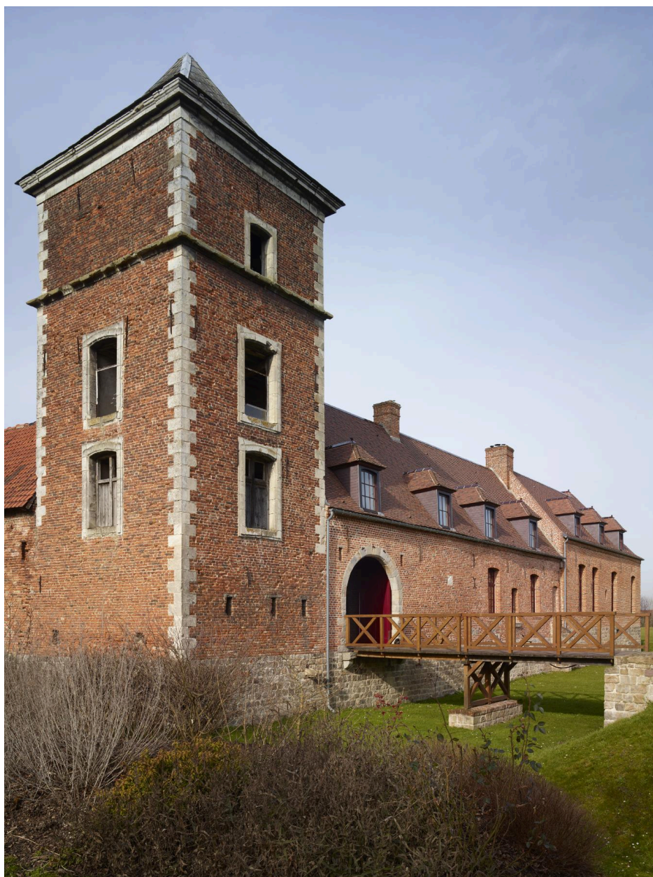
Angle sud-est de la ferme. Tour d'angle et seconde entrée charretière.
