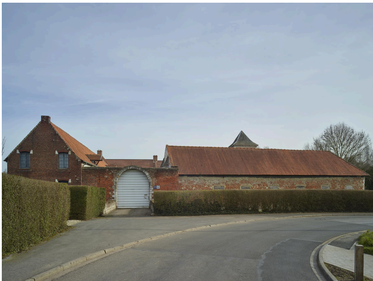
Façade sur rue. Entrée charretière et logis sur la gauche.
