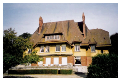
Façade postérieure sud. Phot. Gilles-Henri Bailly IVR22_20158005326NUCA
