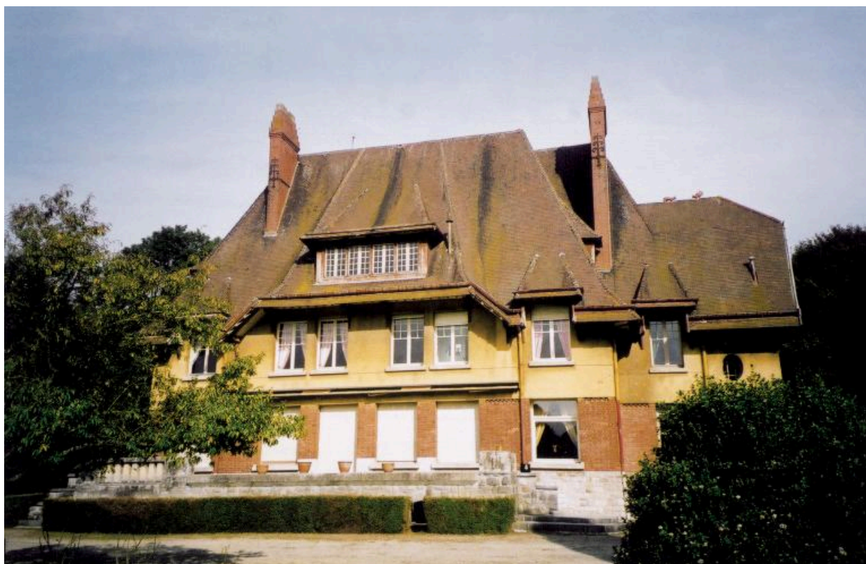
Façade postérieure sud.
