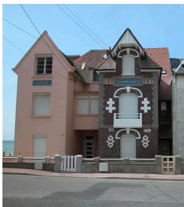
Vue d'ensemble, façade d'entrée sur rue. Phot. Elisabeth Justome IVR22_20058003298NUCA
