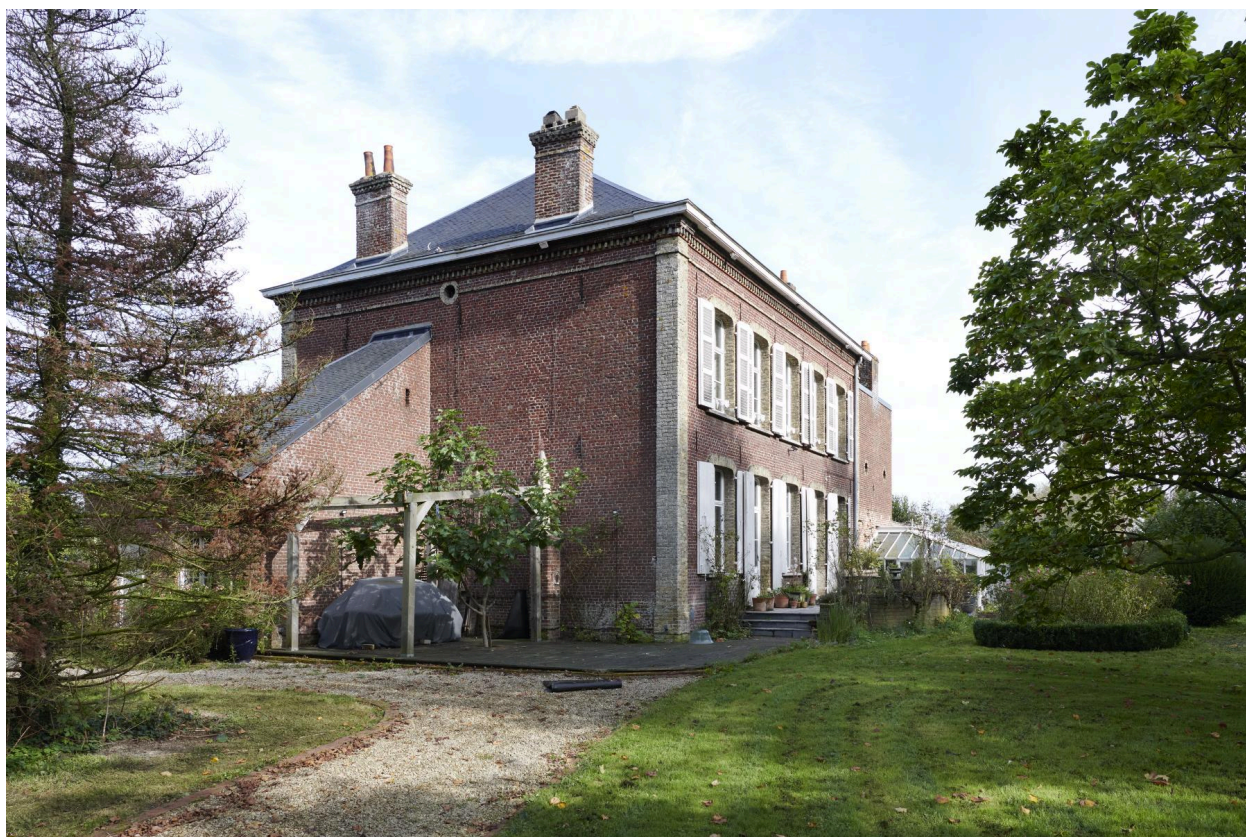
Module ouest. Pignon et façade sur jardin.
