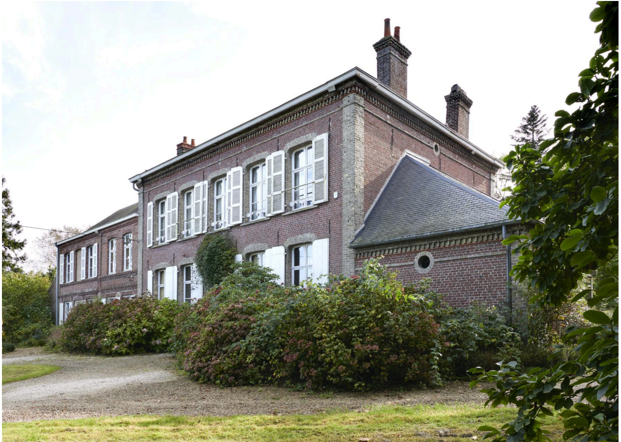
Module d'habitation ouest avec son extension sur pignon.
