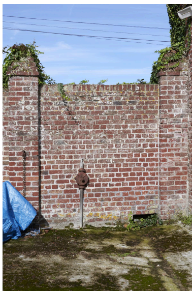
Détail du mur de clôture. Phot. Delphine Volto Jourdan IVR32_20255900824NUCA
