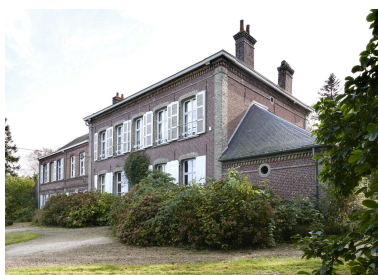
Module d'habitation ouest avec son extension sur pignon. Phot. Delphine Volto Jourdan IVR32_20255900822NUCA
