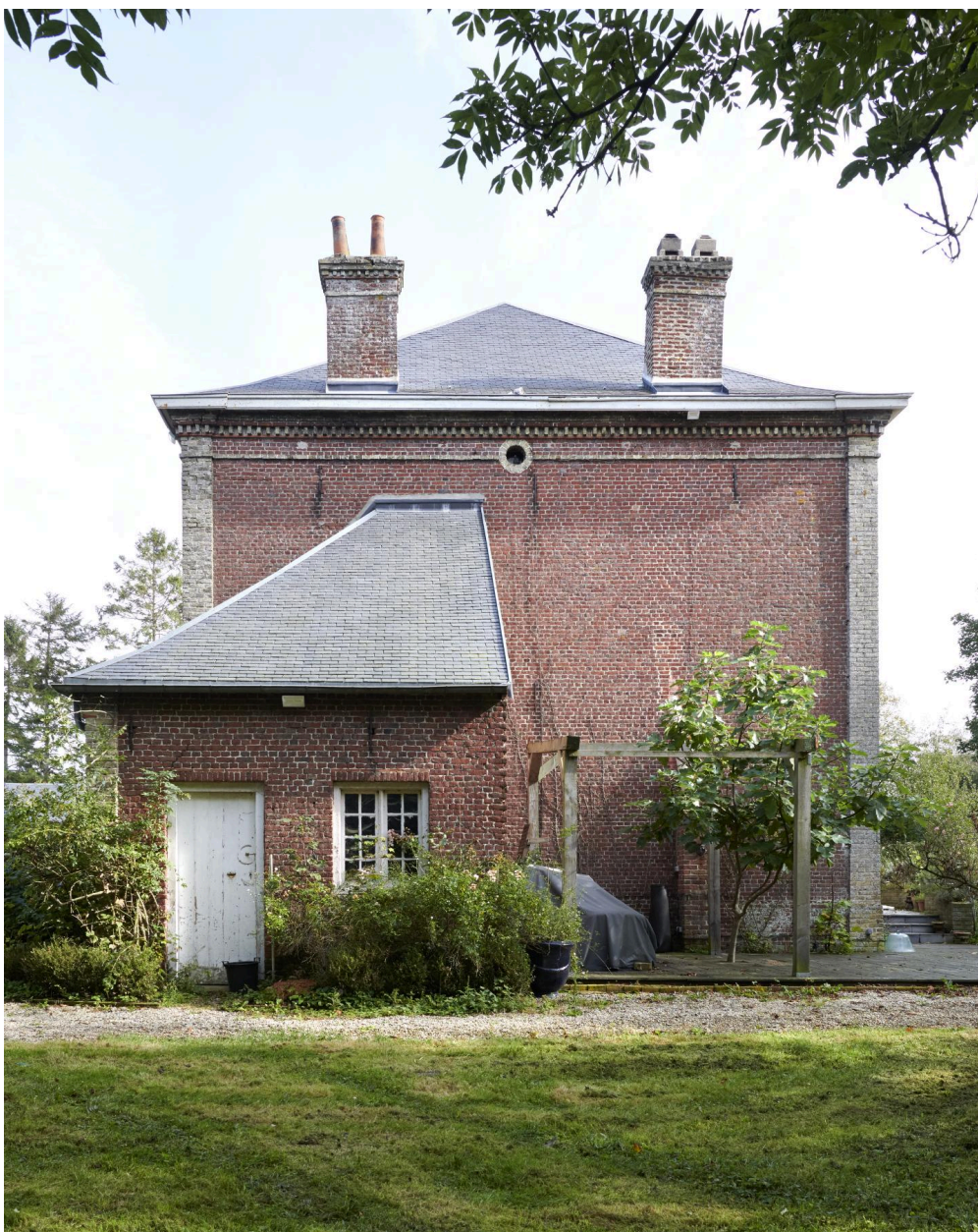
Extension du module ouest et pignon ouest de la demeure principale.
