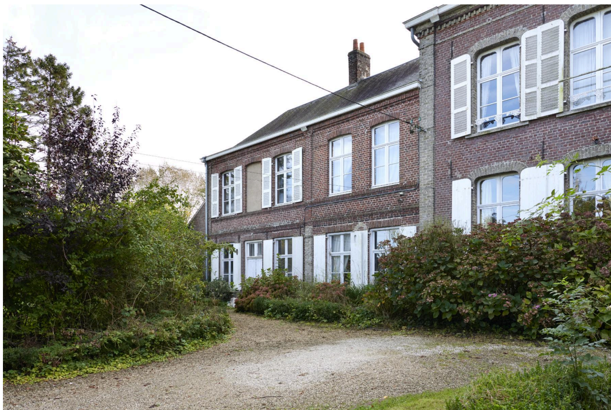
Module est. Façade principale.
