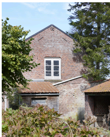
Module est. Pignon est. Phot. Delphine Volto Jourdan IVR32_20255900819NUCA
