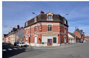
Vue générale sur le pan coupé et les façades rues Jean-Baptiste-lequette et Gambetta depuis la rue Gambetta. Phot. Hubert Bouvet IVR32_20196200920NUC4A
